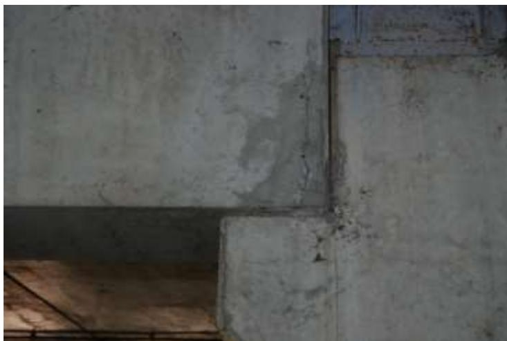
Figura 4: Fissura no canto inferior da viga
