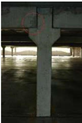
Figura 3: Fissura no canto inferior da viga – Localização
