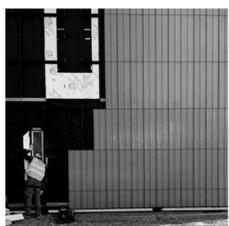
Las fachadas con patrones verticales se componen de piezas cerámicas que generan una fachada ventilada que ayuda a disminuir el calor concentrado. Las piezas se materializan en tres tamaños diferentes, que posicionadas con aleatoriedad provoca una vibración muy dinámica en la fachada.
