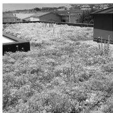
Las cubiertas vegetales extensivas de vivers se componen de plantas autóctonas y precisan de poco mantenimiento. Además suponen un bajo peso, disminuyen la temperatura de la cubierta y generan un plano verde o jardín elevado para las edificaciones más elevadas colindantes.
