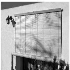
Las persianas enrollables y porticones de madera suponen una protección solar por el exterior que protege el interior de las viviendas de la radiación solar en los períodos de mayor temperatura.
