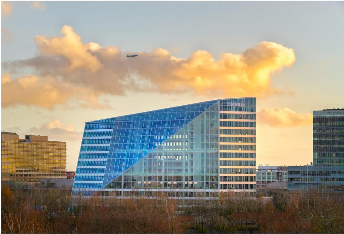
Figura 8. Envolvente tipo Curtain wall edificio The Edge. Fotografía de Ronald Tilleman
