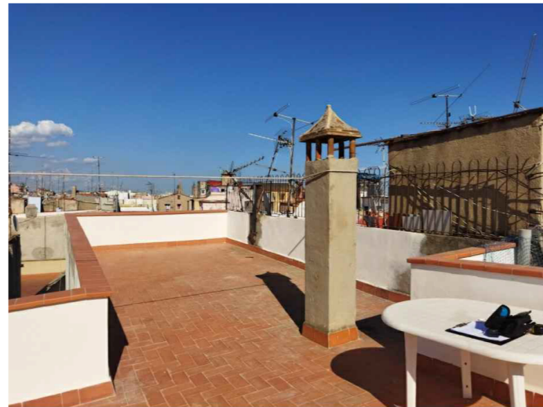
Zona Est de la coberta plana transitable amb paviment de tova ceràmica. Imatge direcció interior d'illa.
