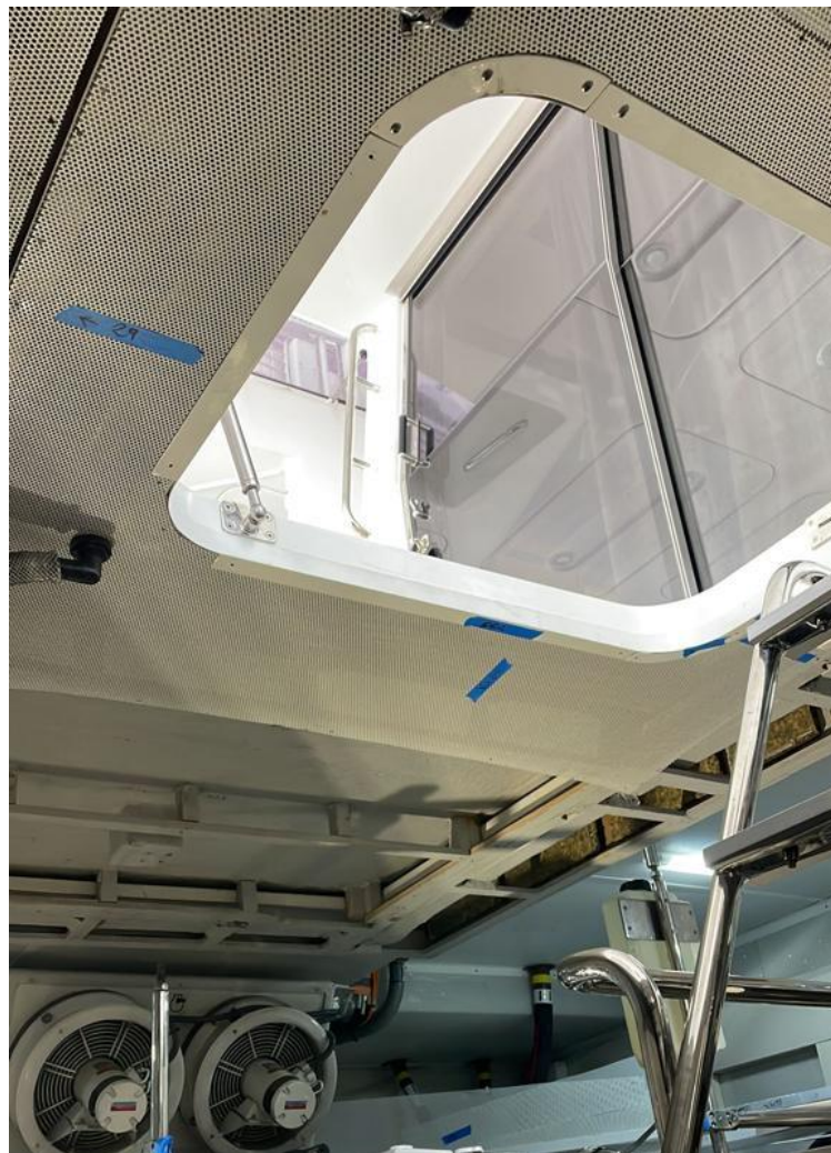
Figura 32: Sostre de sala de màquines parcialment desmuntat
