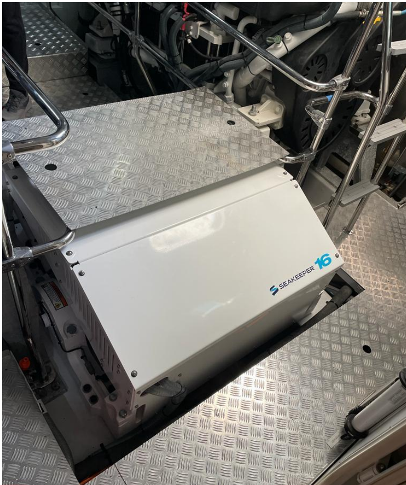
Figura 56: Seakeeper 16 instal·lat amb sala de màquines muntada
