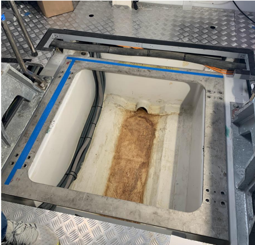
Figura 36: Base del Seakeeper presentada a la bancada
