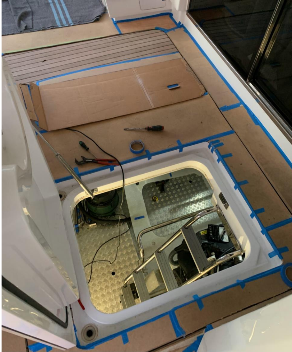
Figura 29: Imatge de la banyera totalment protegida
