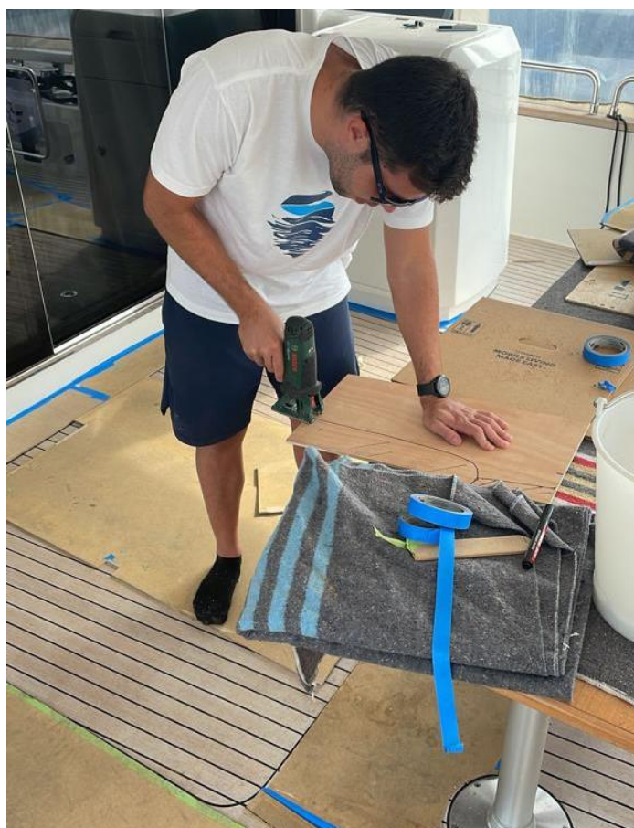
Figura 28: Autor tallant les fustes de protecció
