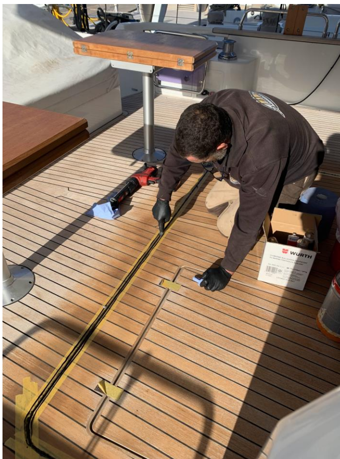
Figura 57: Registre de la sala de màquines amb el Sikaflex sobresortint el carril
