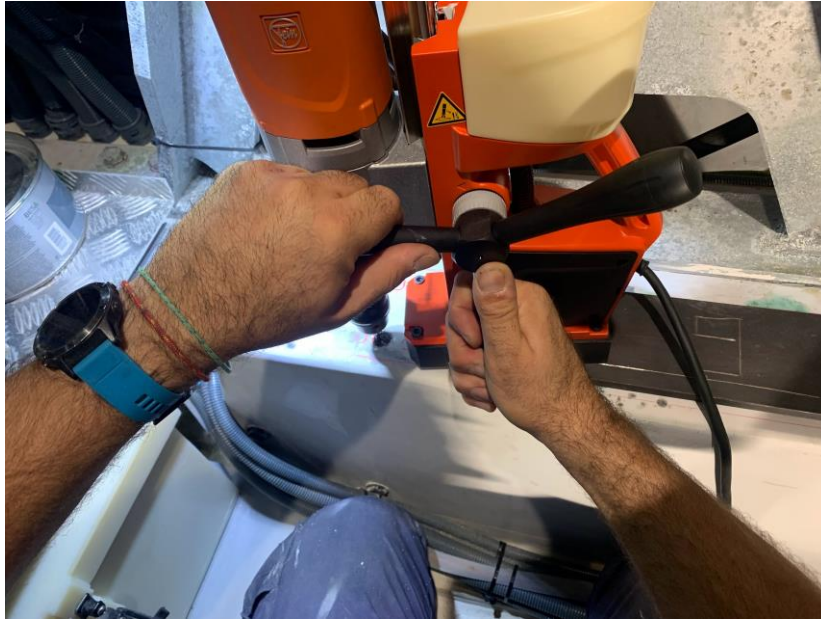
Figura 37: Trepant magnètic perforant la bancada
