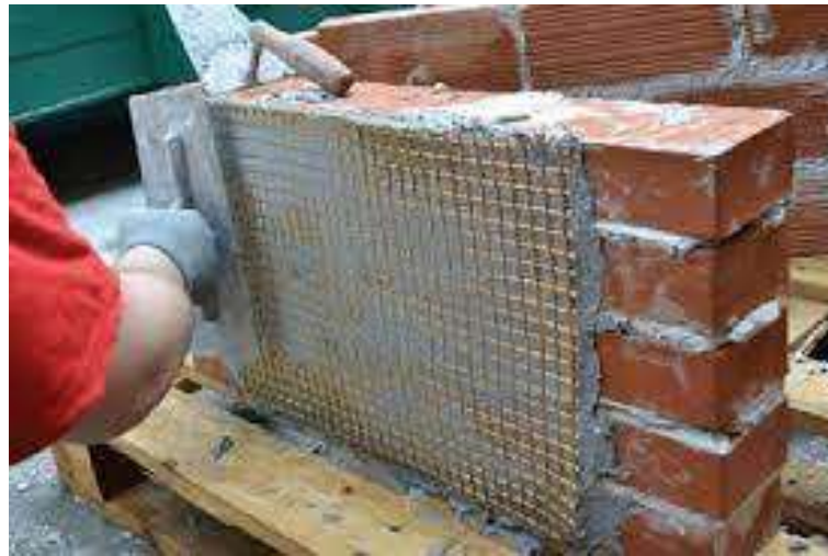
-Figura 1: FCRM como refuerzo de muro [64]
