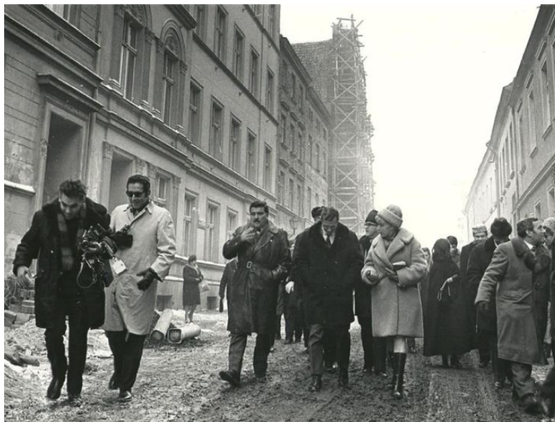
Fot. 4. Zwiedzanie Starego Miasta. W tle remontowany w ramach przygotowań do jubileuszu kopernikowskiego Dom Kopernika. Fot. B. Olechnicki
