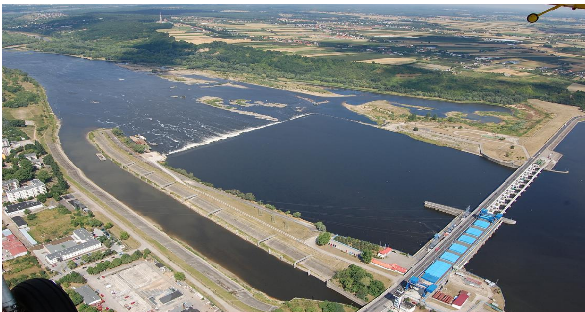
Fot. 1. Zapora ziemna na Wiśle Dolnej we Włocławku zbudowana w latach 1964-1968, o wysokości piętrzenia 11,3 m, obecnie, w wyniku procesu erozji wgłębnej ponad 15 m (fot. Z. Babiński).
