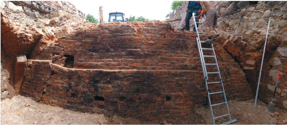
Ryc. 7. Człuchów. Ściana działowa wzniesiona w zachodniej części południowego skrzydła Zamku Wysokiego w celu podparcia sklepień piwnicznych (fot. A. Budzowska)
