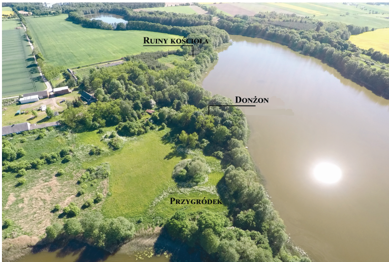
Ryc. 8. Danabórz, pow. wągrowiecki, woj. wielkopolskie. Widok sytuacyjny z północy na założenie obronne wraz z oznaczeniem jego reliktyw (fot. P. Wroniecki; oprac. A. Różański)
