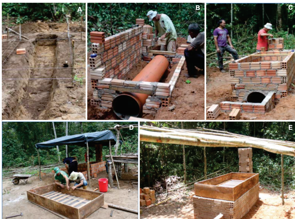
Figura 13. Etapas para construção do secador a ar quente por convecção natural: limpeza, marcação e escavação do terreno para a locação do equipamento (A); assentamento do tubo do trocador de calor (B); execução da alvenaria (C); construção da câmara de secagem (D); e assentamento da câmara de secagem (E).
