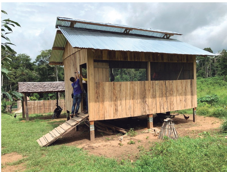
Figura 17. Vista lateral do armazém-secador com ventilação natural para produção familiar.
