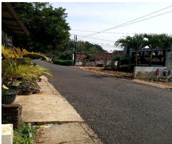
Gambar 5. 3 Kondisi Jalan RT 01 Juli 2022
