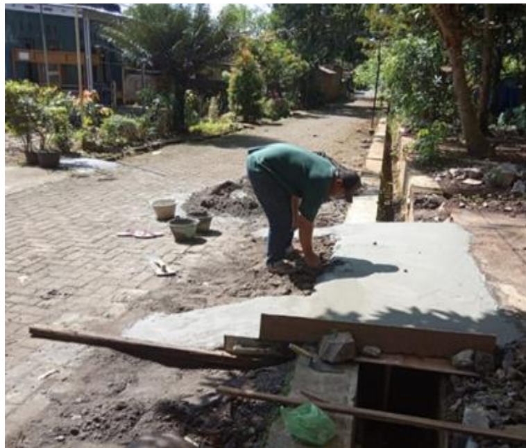
Gambar 5. 1 Pembangunan Jalan Jembatan
