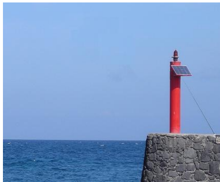
Figura 14. Faro alimentado por paneles fotovoltaicos
