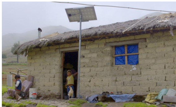
Figura 10. Electrificación en área rural
