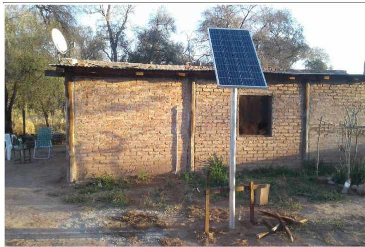
Figura 48. Ejemplo de ubicación de los paneles fotovoltaicos en áreas rurales
