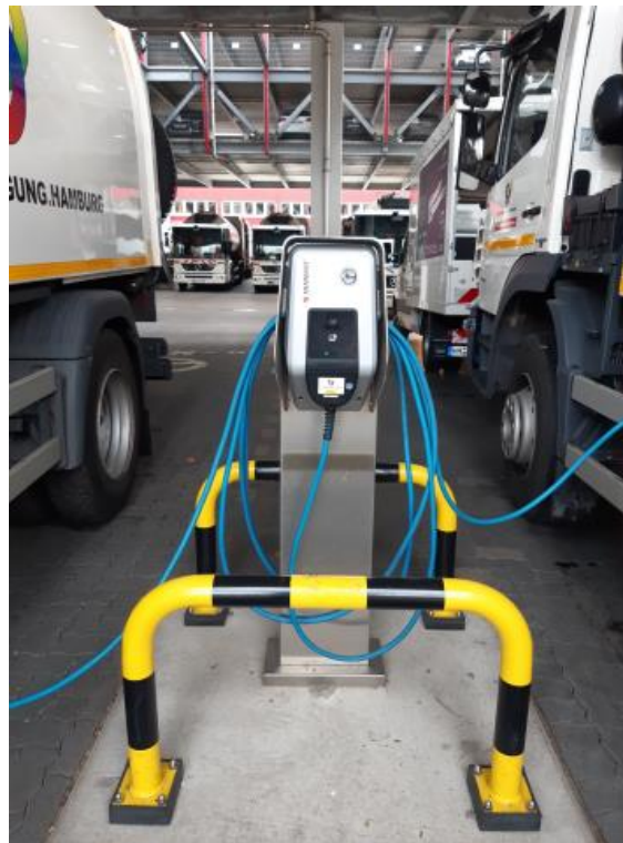
Abbildung 23: Ladestation der Firma Mennekes Elektrotechnik GmbH & Co. KG (M. Schwarz, SRH, persönliche Kommunikation, 2020)
