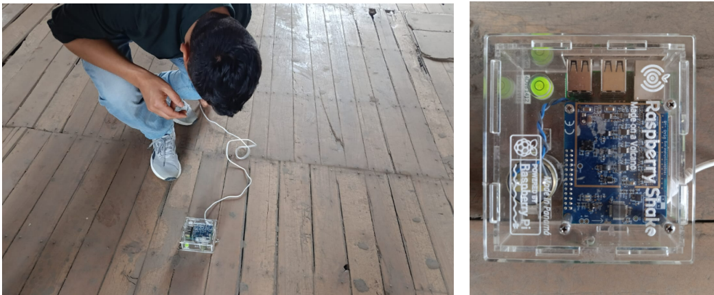
Fotografía 4 Instalación del equipo Raspberry Shake
