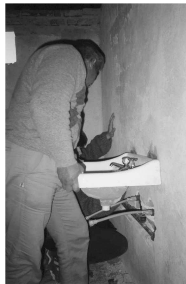
Fotografía 2: trabajos de instalación sanitarias.
