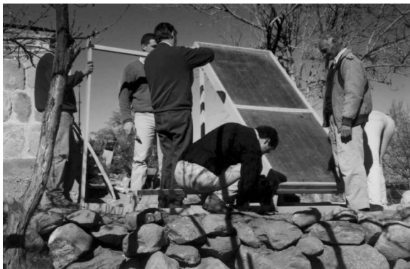
Fotografía 1: Equipo de trabajo instalando los captadores.
