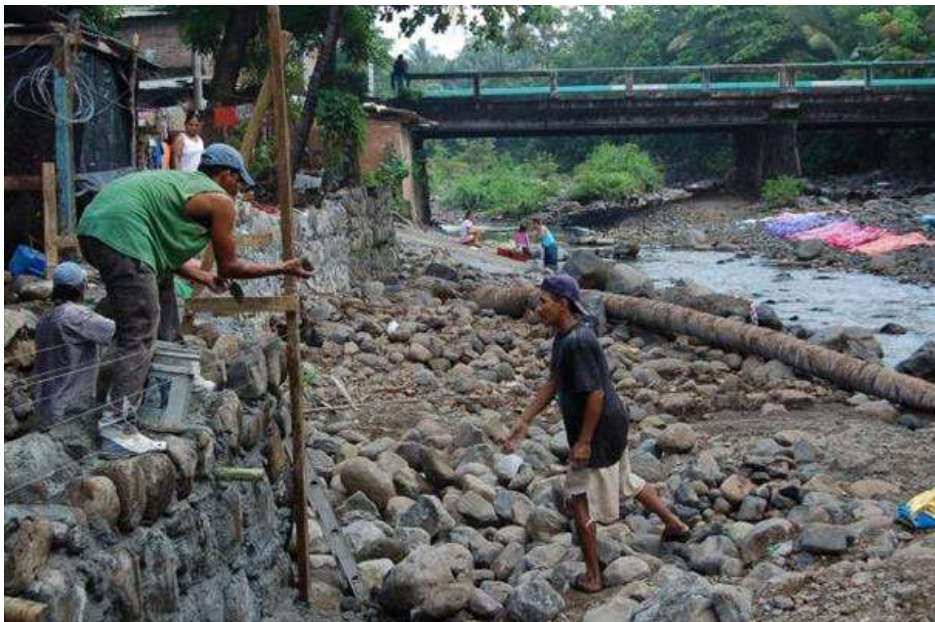
Figura 5.14 Construcción de muro de retención a orilla de Rio para evitar inundaciones.
