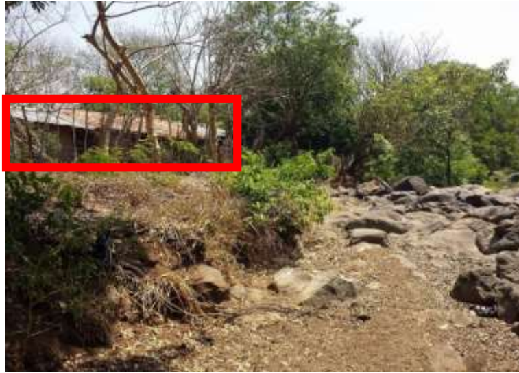
Figura 4.6 Imagen que muestra la vulnerabilidad de las viviendas debido a su cercanía al río y su tipo de material usado. Fuente propia (Fotografía tomada en mayo de 2017).
