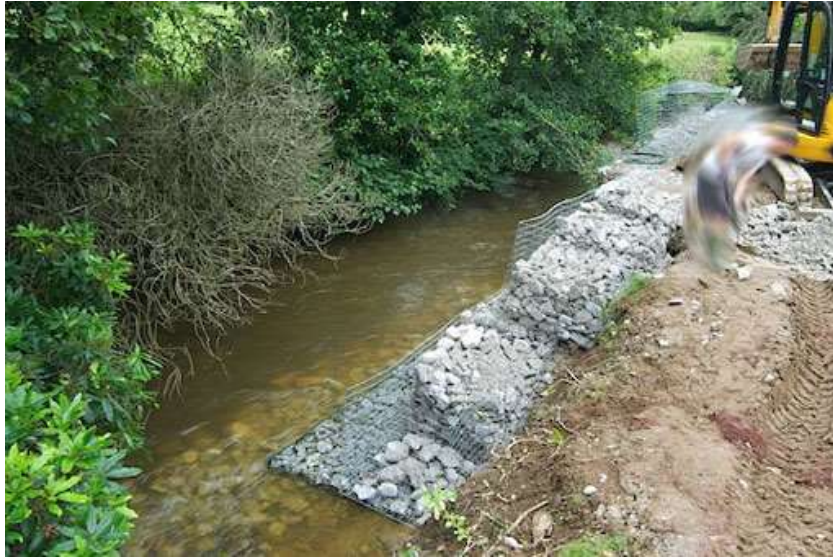
Figura 5.15 Creación de bordas (gaviones) para evitar que el nivel de caudal entre a terreno natural o vivienda.
