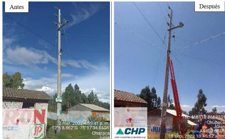
Figura 29. Comparativa antes y después de la instalación del seccionador monopolar SECI
