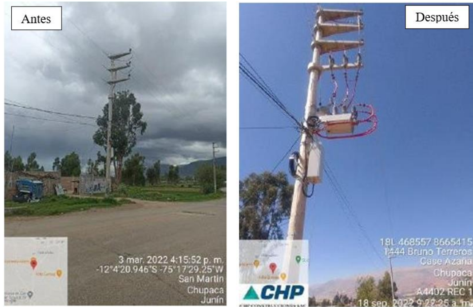
Figura 28. Comparativa antes y después de la instalación recloser trifásico RECI
