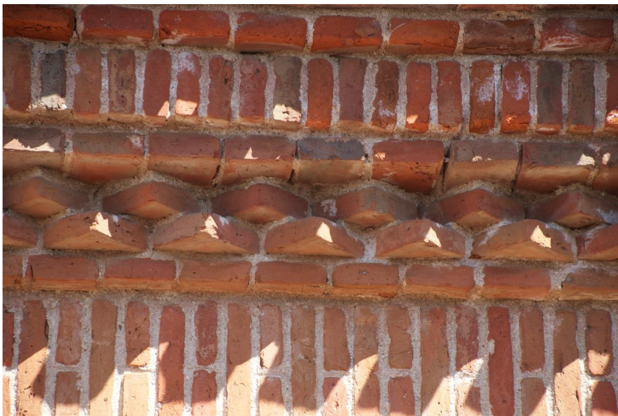
Figura 8. Detalle de la torre norte.
