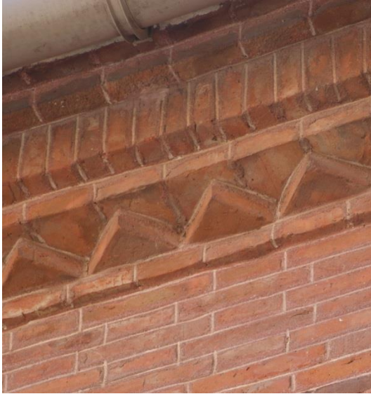
Figura 48. Detalle de la capilla del cementerio.
