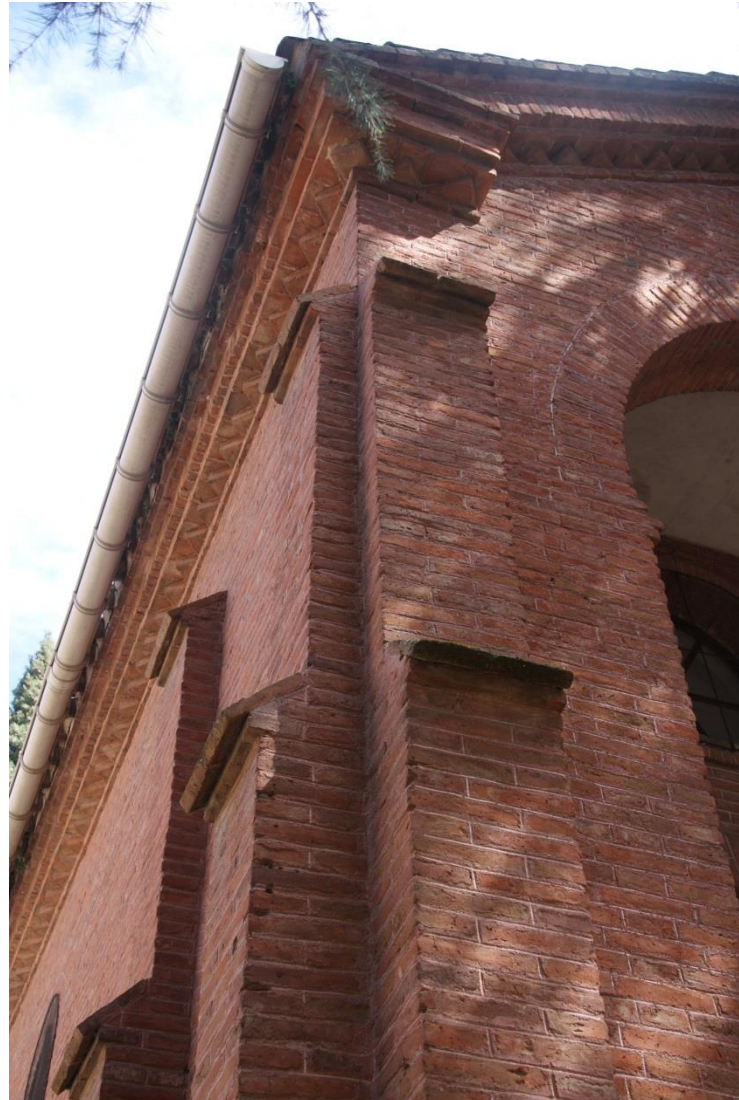
Figura 47. Detalle de los contrafuertes de la capilla del cementerio.
