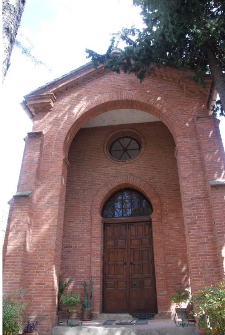
Figura 50. Fachada de la capilla del cementerio.
