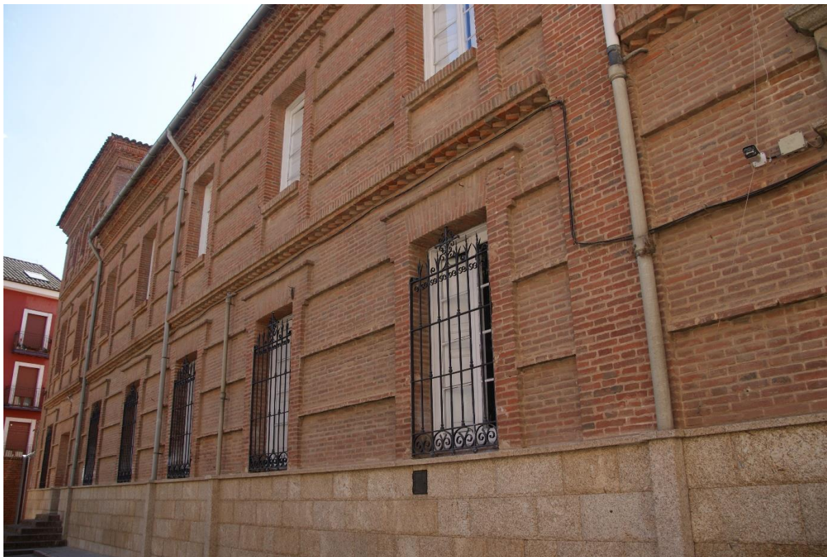
Figura 19. Fachada principal recorrida por vanos adintelados.
