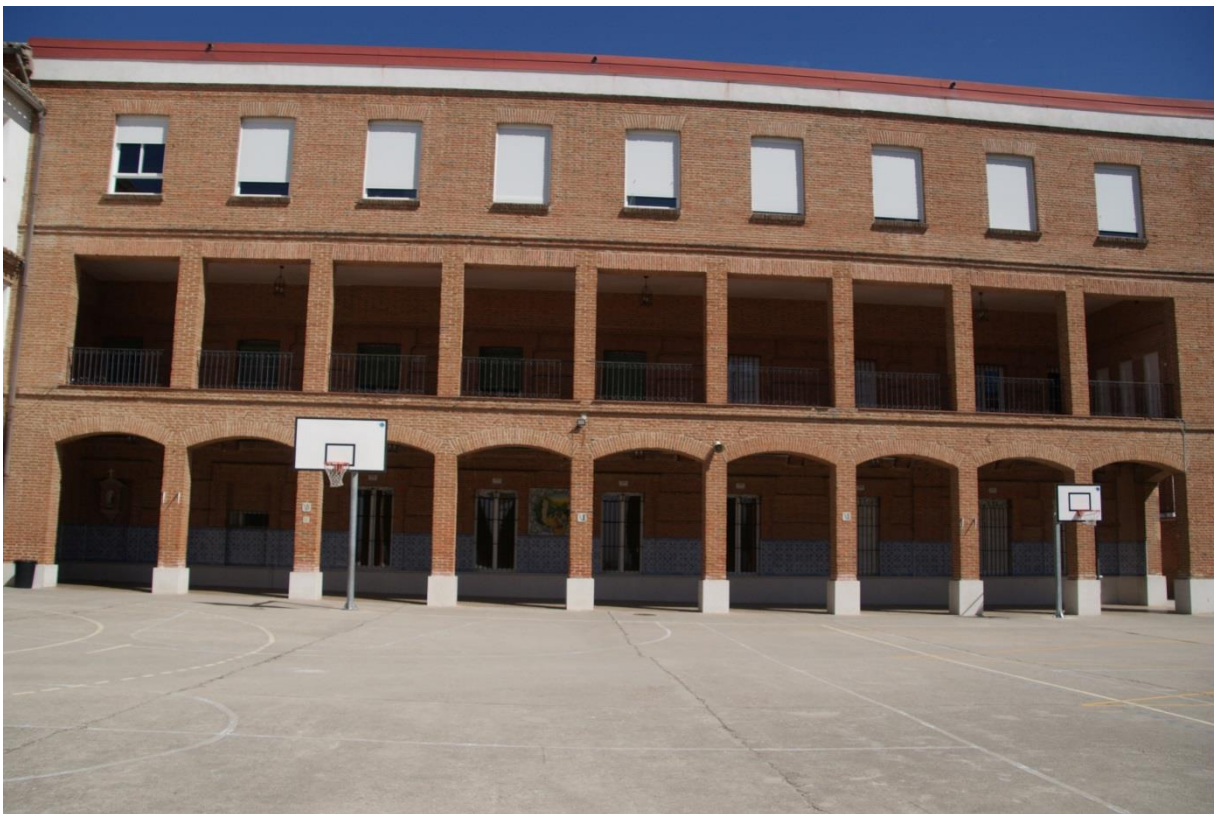
Figura 51. Exterior del edificio. Tercera planta: Educación Primaria.
