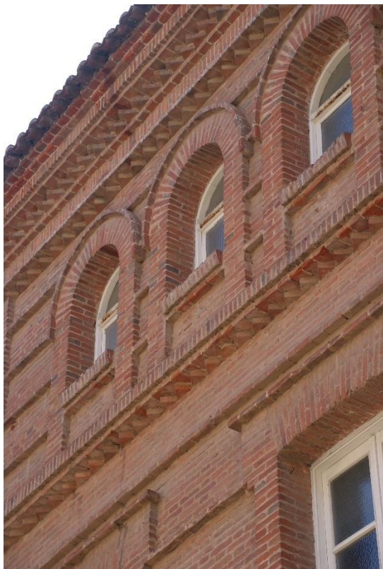
Figura 20. Detalle del tercer piso de la torre sur.
