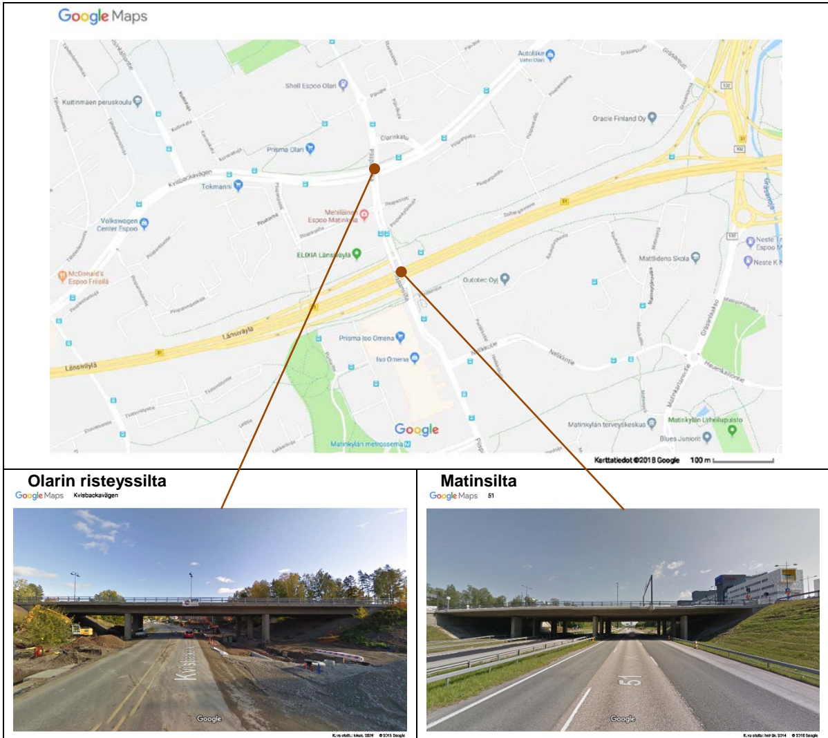
Kuva 1. Olarin risteyssilta ja Matinsilta.
