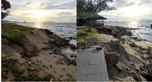
Gambar 13. Kondisi Fisik Pesisir Terdampak Abrasi dan Kerusakan Bangunan di Pesisir Pantai (Hasil Analisis, 2022)
