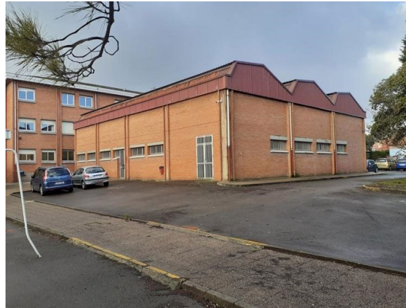
Figura 2.-Foto exterior de la instalación
