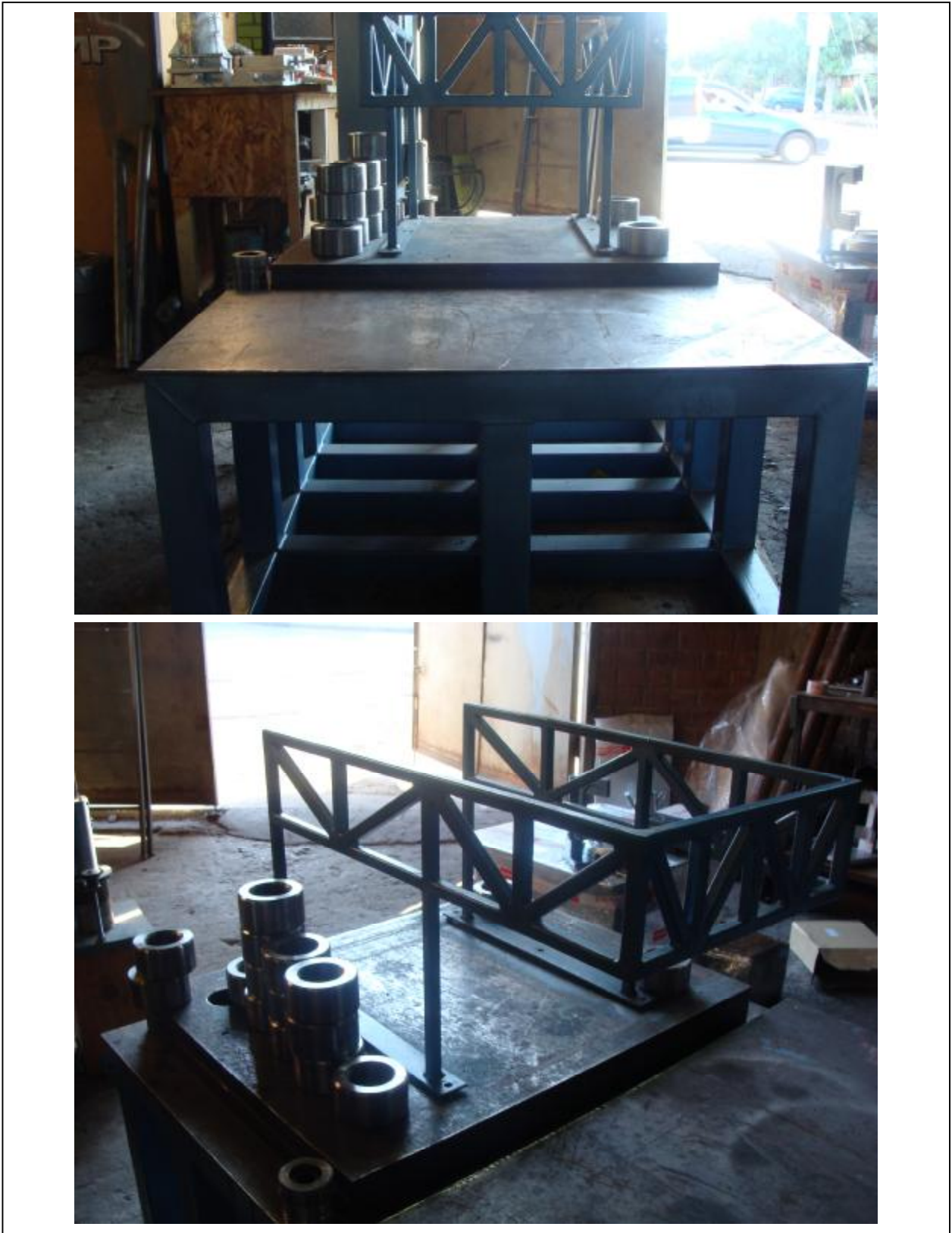
Fig. Anexo A.4.4.- Construcción marco de carga triaxial, 1.
