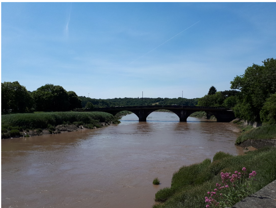
Fig 1: Caerleon, Usk Bridge
