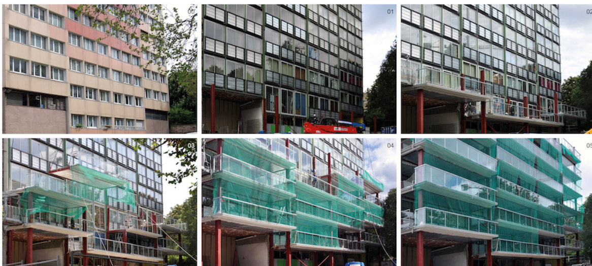
Figura 20. Proceso de sustitución de carpinterías e instalación de los jardines de invierno. Torre Bois-Le-Petre
