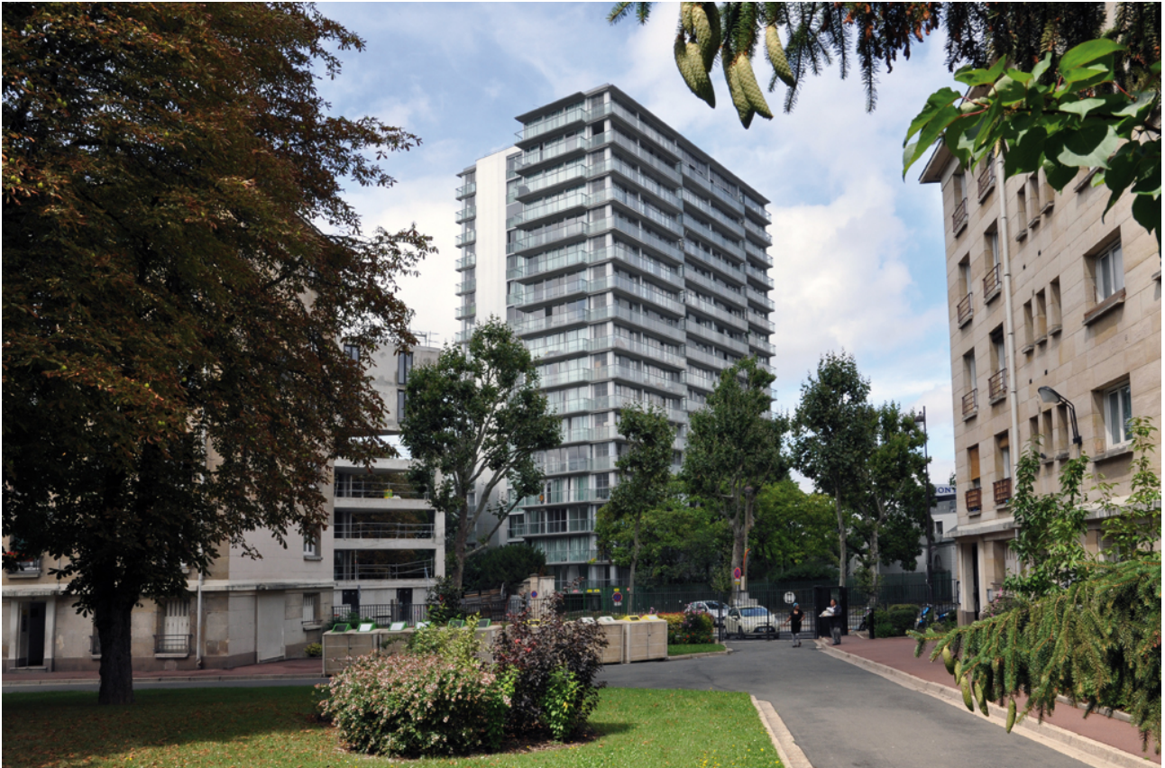
Figura 15. Vista desde la calle. Torre Bois-Le-Petre
