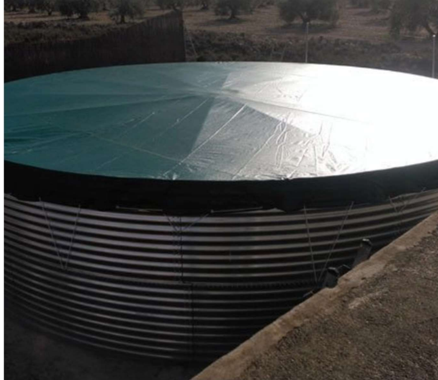
Ilustración 44 Depósito de agua
