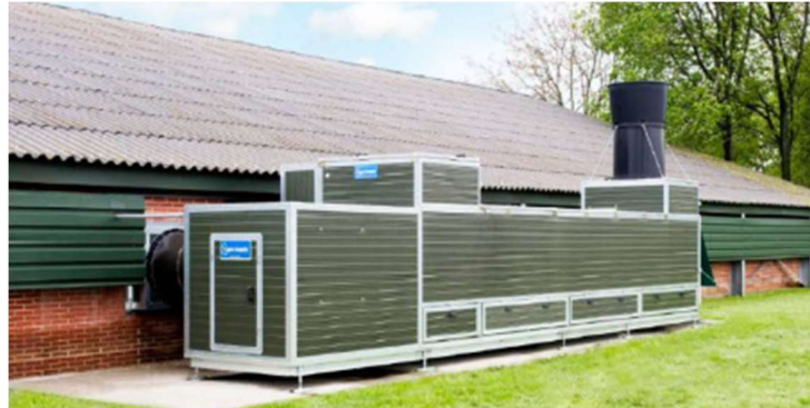
Ilustración 33 intercambiador de calor
