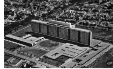
Figura 27, Hospital Edgardo Rebagliati.
