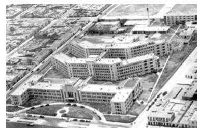
Figura 26, Hospital Guillermo Almenara. Fuente: http://blog.pucp.edu.pe/?a
