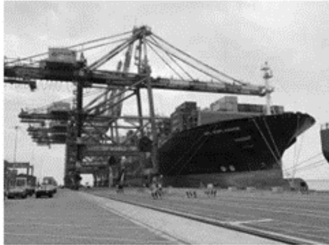
Figura 29: Nave de diseño de aguas abrigadas. Recuperado de OSITRAN, 2021
