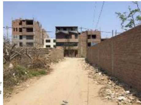
Figura 80 Calle S/N. Elaboración propia (2018)
