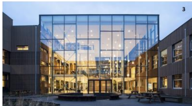
VISTA AL ATRIUM
