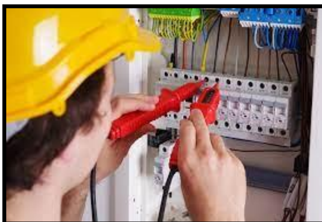
Ilustración 31 Detección de fugas eléctricas
