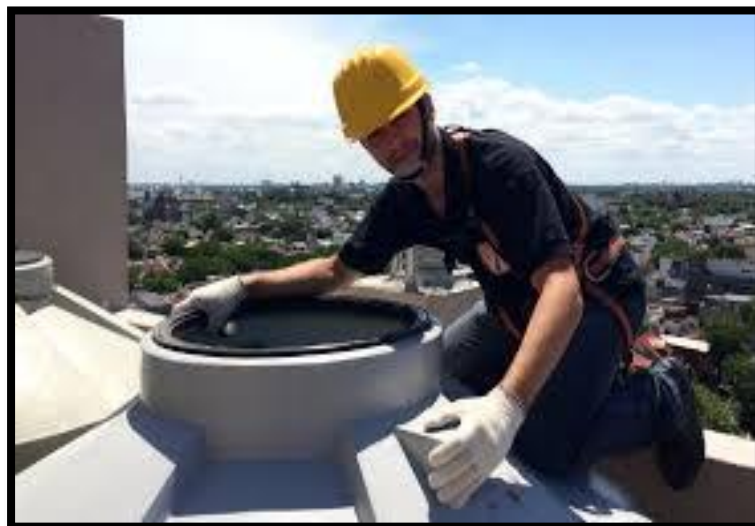
Ilustración 35 Mantenimiento de cisterna
