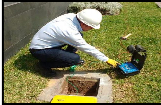
Ilustración 32 pozos a tierra
