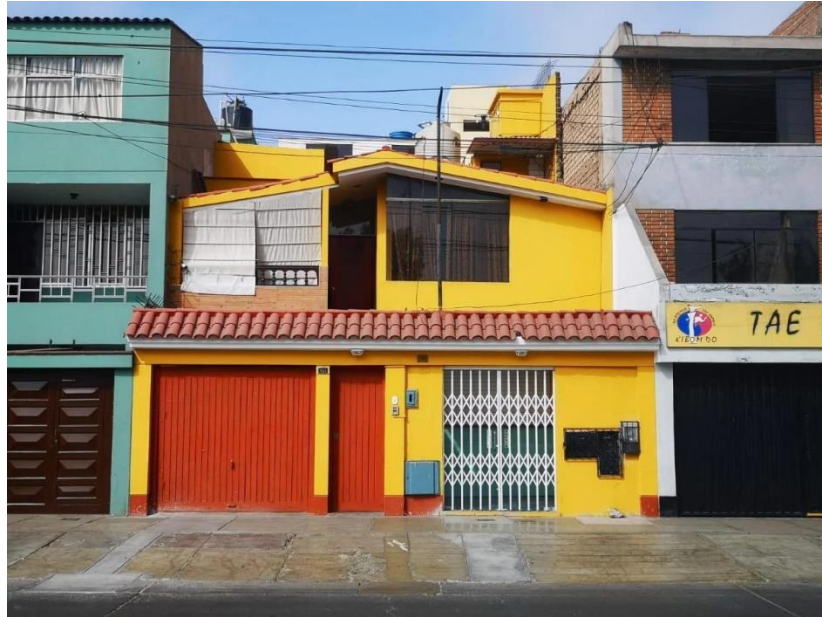
Figura 51 Fachada del local
