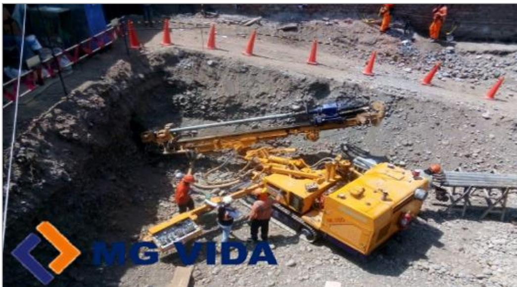
Fotografía 2: Trabajos de perforación y anclaje
