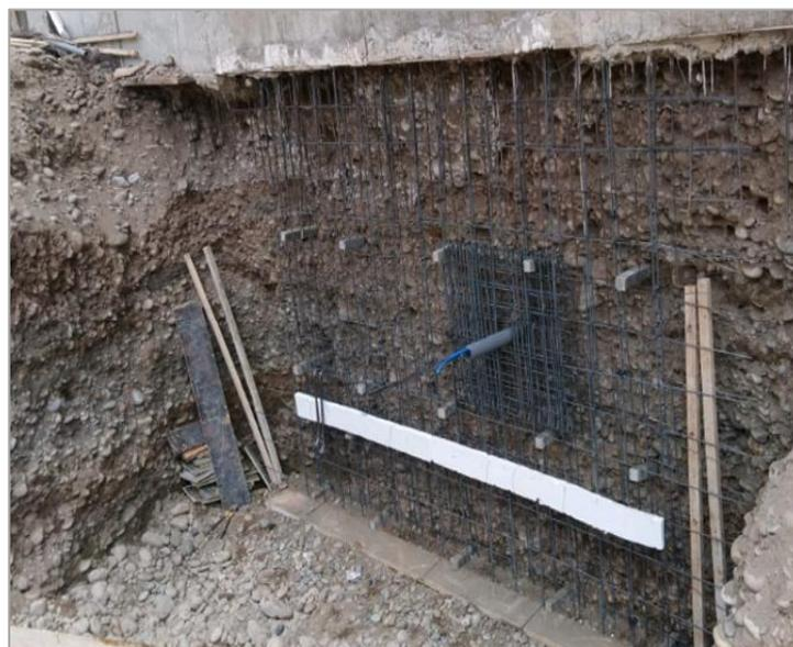
Fotografía 6: Instalación de tacos de concreto para alinear el encofrado
