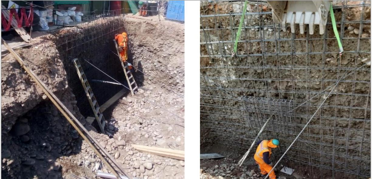
Fotografía 4: Izaje y colocación la malla de acero corrugado para muros anclados
