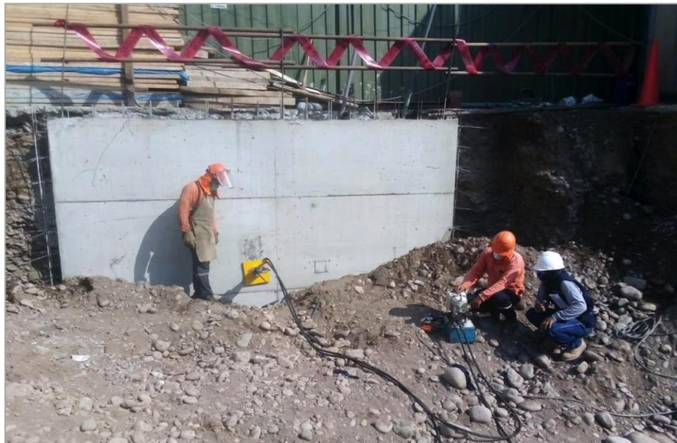
Fotografía 8: Tensado de muros de anclados
