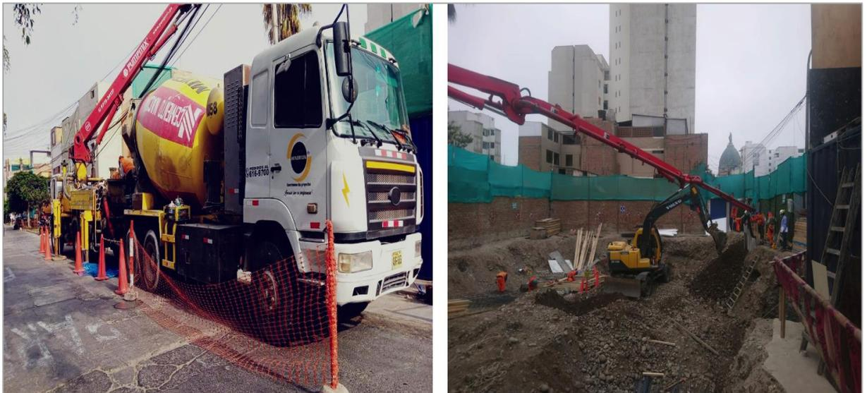
Fotografía 7: Vaciado de concreto premezclado con bomba tipo pluma
