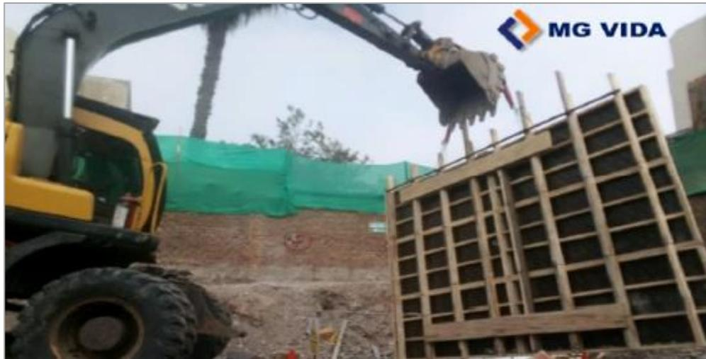
Fotografía 5: Izaje de panel fenólico para encofrado de muros anclados
