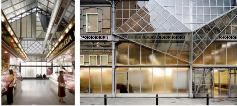
Fotografía 29 Cobertura y Fachada
