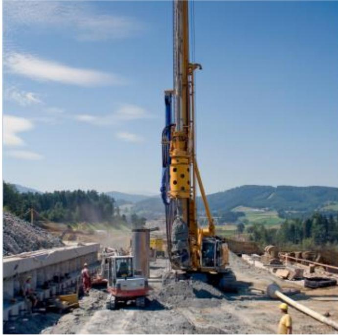
*Figura 4-51 Pilotes con Entubación (Pilotes Keller, s/f)*
