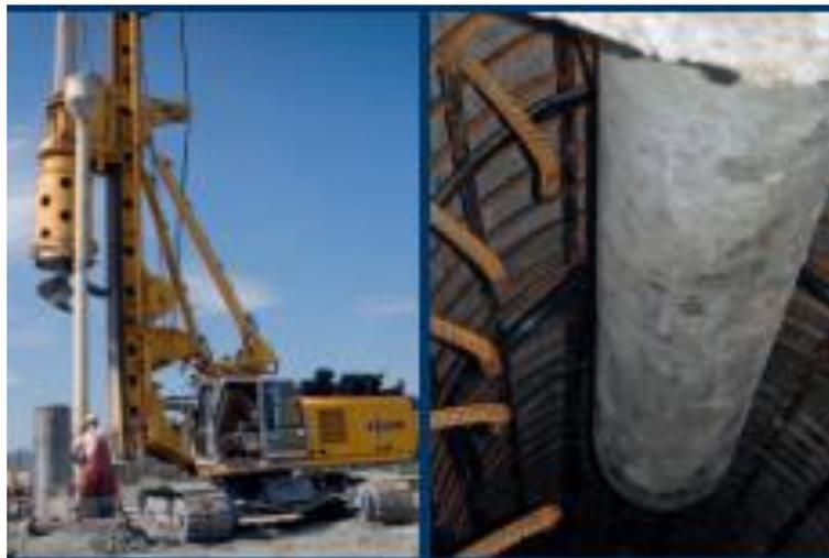
*Figura 4-52 Colocación del concreto a través del tubo Tremie (Pilotes Keller, s/f)*
