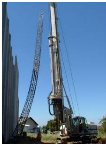
Figura 4-48 Colocación de Armadura en Pilotes Primarios
