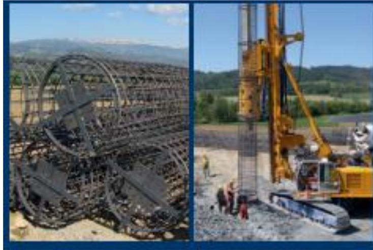
Figura 4-49 Habilitación y Colocación de Armadura (Pilotes Keller, s/f)
