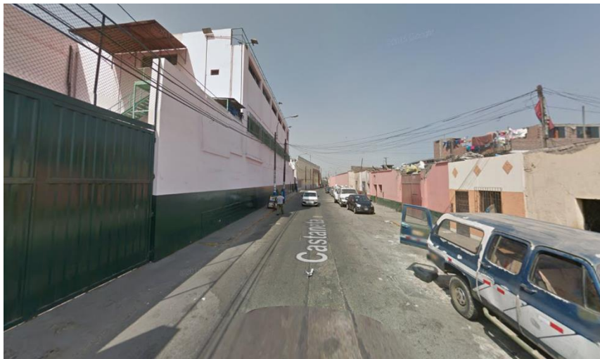
Al lado izquierdo un edificio industrial. Fuente: google maps
