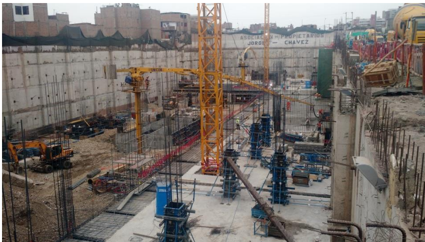
Figura 398. Avances del C.C Plaza Surco (frente 1 y 2), durante la etapa II. Fuente: Propia.
