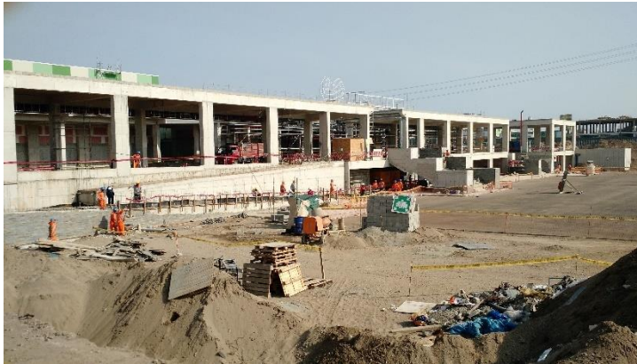
Figura 47. Ejecución del Centro Comercial “Mega Plaza Villa el Salvador II”. Fuente propia
