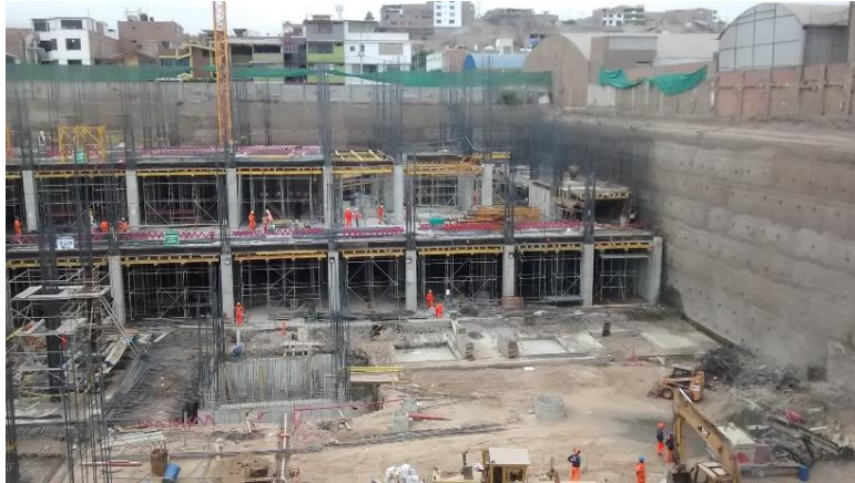
Figura 20. Avances del Mall del Sur (Frente 3 y 4). Fuente: J. E. Contratistas
