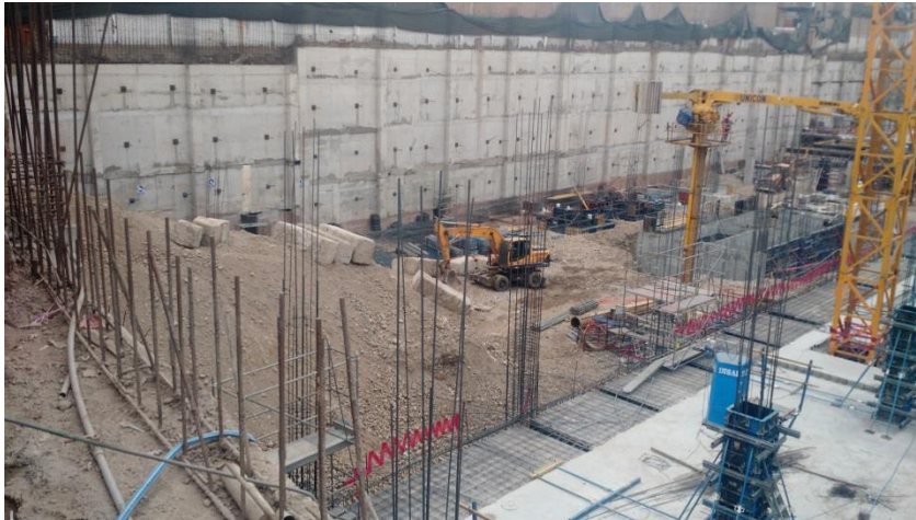
Figura 38. Avances del C.C Plaza Surco (frente 2), durante la etapa II (rampa de tierra). Fuente: Propia.
