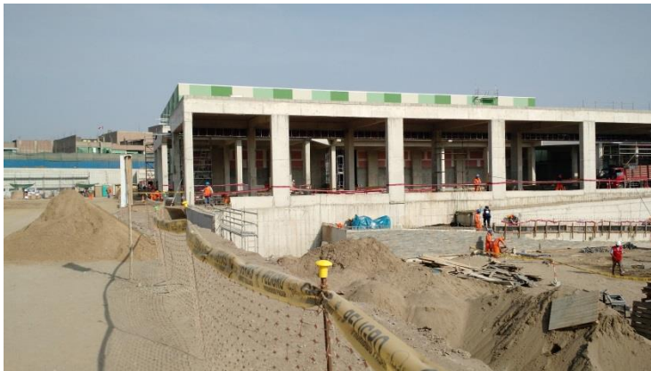
Figura 48. Ejecución del Centro Comercial “Mega Plaza Villa el Salvador II”. Fuente propia
