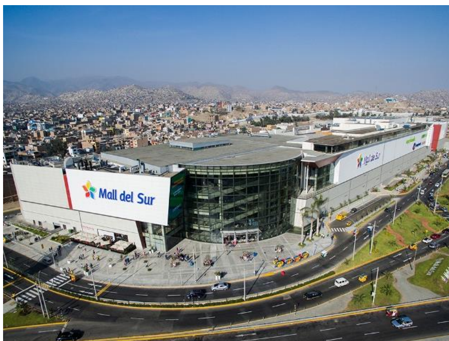
Figura 16. Proyecto culminado del Centro Comercial Mall del Sur. Fuente: Empresa Consultora Antonio Blanco Blasco Ingenieros EIRL
