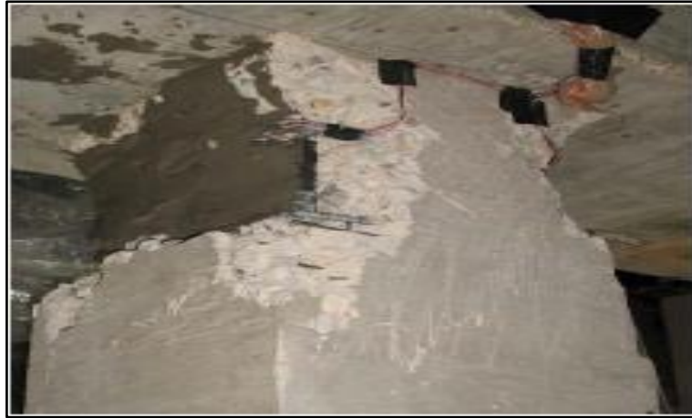
Figura 53: Aplicación de mortero de reparación y CFRP en la parte superior.
