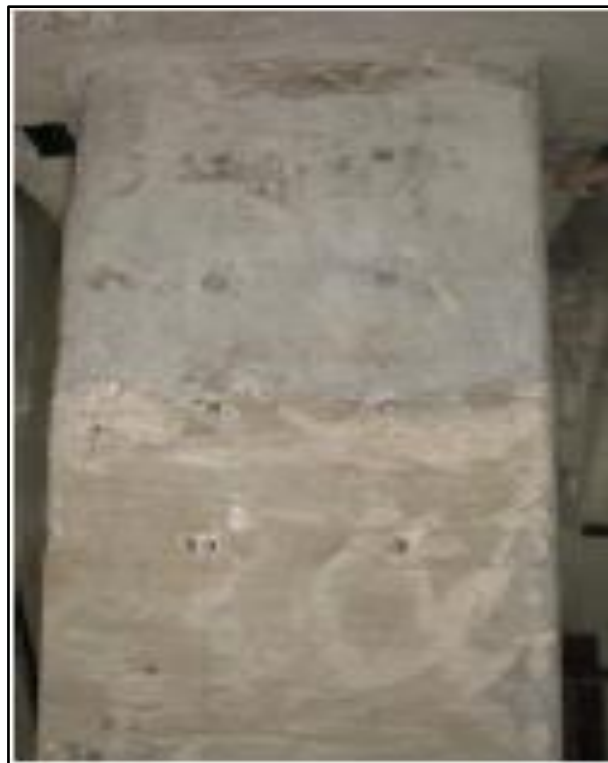
Figura 54: Agujeros perforados para la Instalación del Anclaje CFRP.
