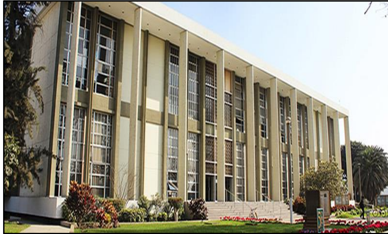
Figura 4: Edificio de la Biblioteca Agrícola Nacional.
