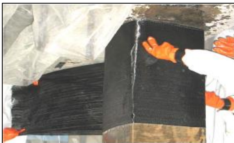
Figura 55: Aplicación de la hoja de CFRP (Chaqueta) en la parte superior de la Columna.
