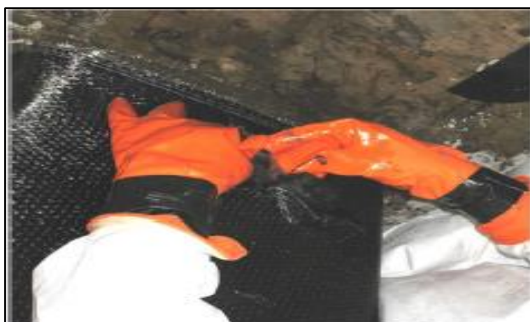
Figura 56: Aplicación de los Anclajes CFRP.
