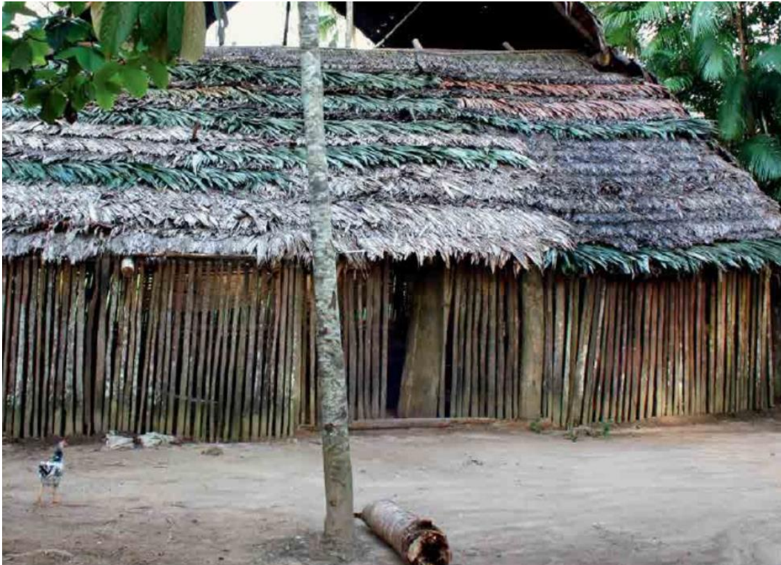
Figura 42. Vivienda liviana construida con material natural en la ciudad de Iquitos. Adaptado de “Iquitos – Telefónica”, por Santos, 2014
