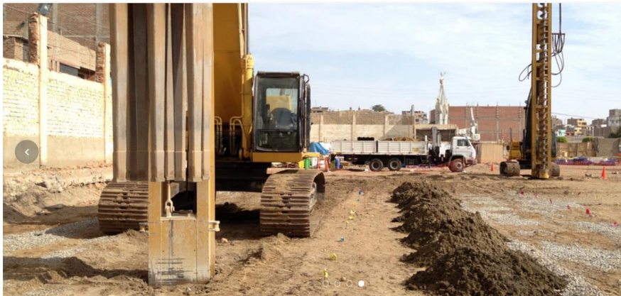
Figura 27. Proceso Constructivo para la instalación de las Pilas de Gravas Compactadas: Perforación helicoidal del terreno natural, Adaptado de " http://www.emin.pe/portfolio/supermercado-pacasmayo/ ", por EMIN GEOESTRUCTURAS, 2016
