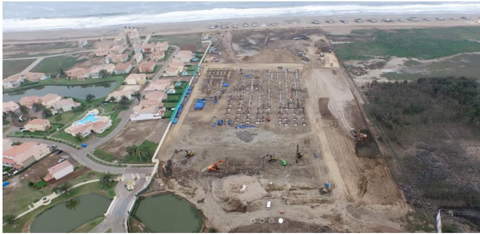
Figura 23. Proceso Constructivo para la instalación de las Pilas de Gravas Compactadas: Vista panorámica del área de trabajo, Adaptado de " http://www.emin.pe/portfolio/centro-comercial-lurin/ ", por EMIN GEOESTRUCTURAS,
