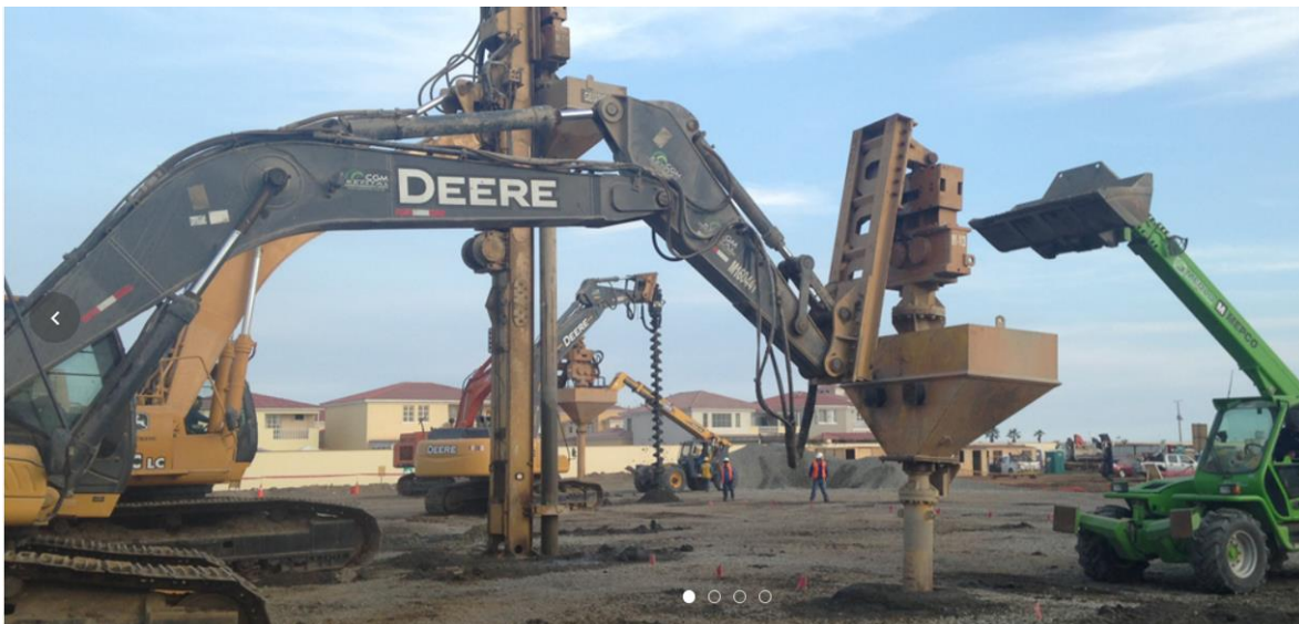
Figura 20. Proceso Constructivo para la instalación de las Pilas de Gravas Compactadas tipo Impact: Llenado y compactación de agregados en el bulbo y fuste de la Pila., Adaptado de " http://www.emin.pe/portfolio/centro-comercial-lurin/ ", por EMIN GEOESTRUCTURAS, 2016.
