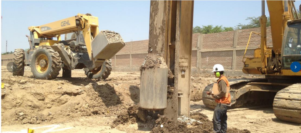
Figura 19. Proceso Constructivo para la instalación de las Pilas de Gravas Compactadas: Llenado y compactación de agregados en el bulbo y fuste de la Pila., Adaptado de “ http://www.emin.pe/portfolio/supermercado-chepen/ ”, por EMIN GEOESTRUCTURAS, 2016
