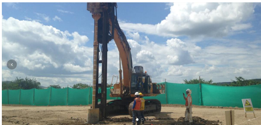
Figura 26. Proceso Constructivo para la instalación de las Pilas de Gravas Compactadas: Colocación de camisas o tubo casing para estabilización de la perforación, Adaptado de " http://www.emin.pe/portfolio/supermercado-jaen/ ", por EMIN GEOESTRUCTURAS, 2016
