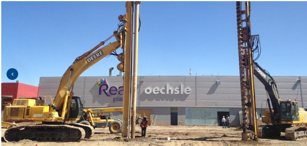
Figura 29. Proceso Constructivo para la instalación de las Pilas de Gravas Compactadas: Perforación helicoidal del terreno natural, Adaptado de “ http://www.emin.pe/portfolio/supermercado-juliaca/ ”, por EMIN GEOESTRUCTURAS, 2016
