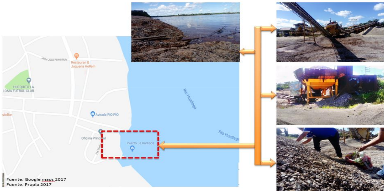
Figura 58. Detalles del Puerto La Ramada ubicado en Yurimaguas, provincia Alto Amazonas, Región Loreto Adaptado de "Elaboración propia", por Obregón, 2017
