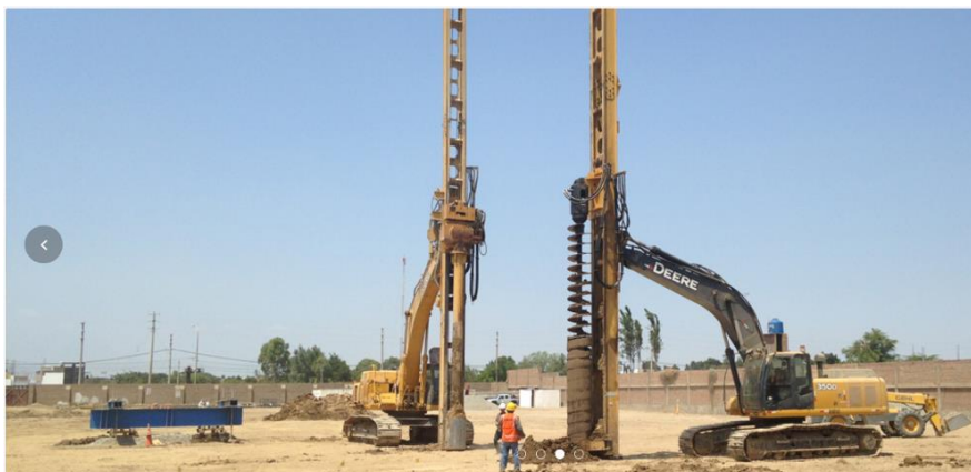
Figura 28. Proceso Constructivo para la instalación de las Pilas de Gravas Compactadas: Perforación helicoidal del terreno natural, Adaptado de " http://www.emin.pe/portfolio/supermercado-chepen/ ", por EMIN GEOESTRUCTURAS, 2016
