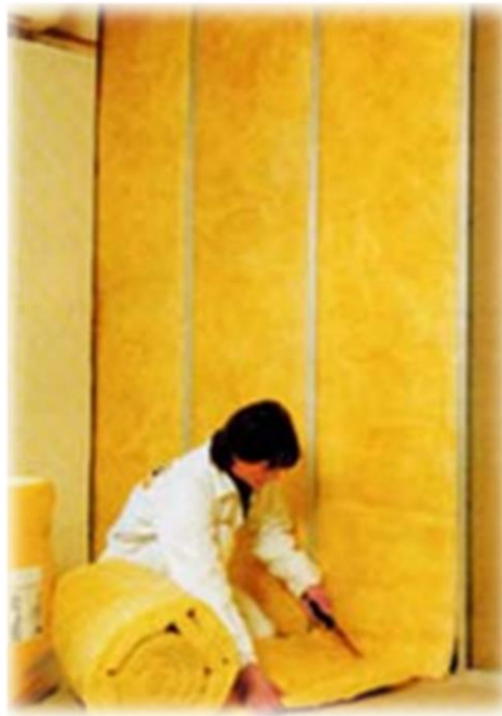
Figura 22: Colocación de lana de vidrio. Fuente: Adaptado de HyN Empaquetaduras e Importaciones SAC, 2021
