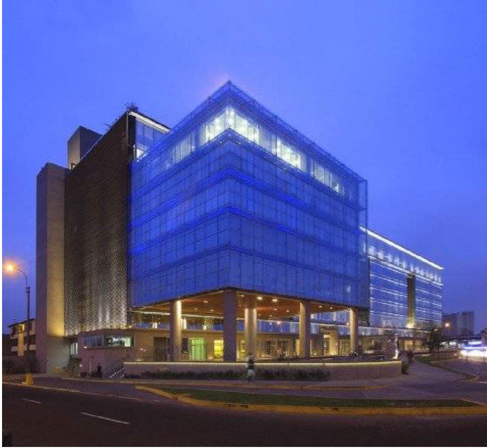
Figura 29: Vista exterior del edificio Cronos en Surco
