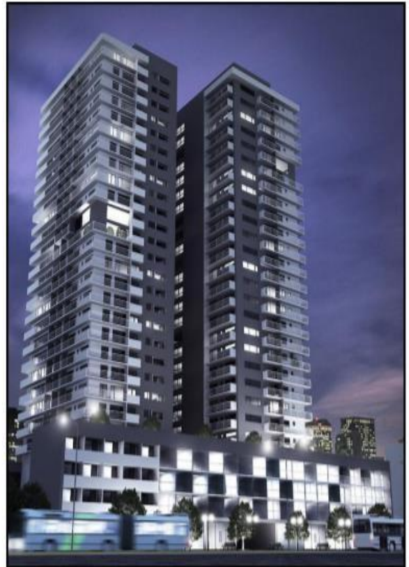
Figura 8: Edificio Ñuñoa Capital
