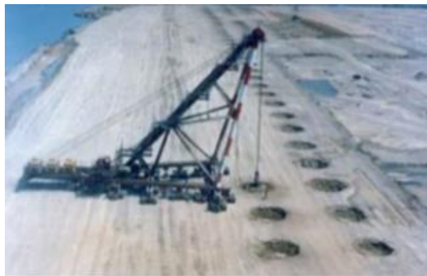
Figura 10: Compactación dinámica con equipos de elevación usada en el proyecto de aeropuerto de Niza. (Coronilla 2015)
