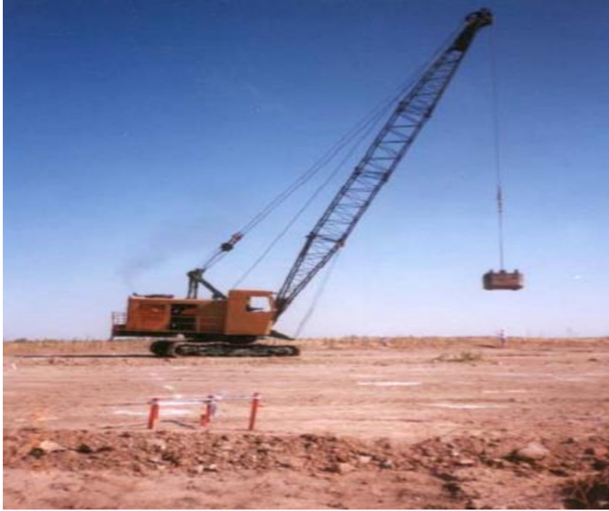
Figura 11: Equipo de compactación dinámica (Zamora: 2013)
