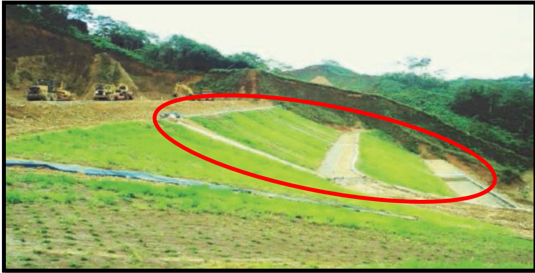
Figura 22. Hidrosiembra en Sector Las Vegas, carretera Tingo María – Aguaytía, por Dendro 2015.
