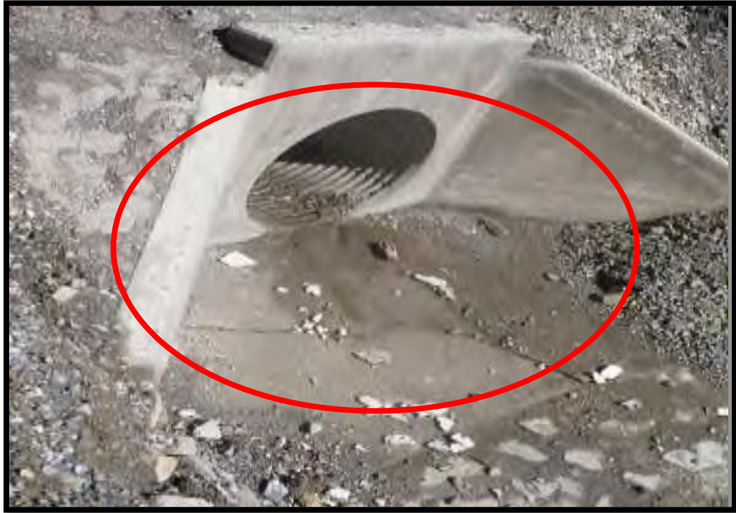
Figura 13. Falla por desplazamiento de emboquillado de alcantarilla Churín–Oyón. Núñez, 2014.
