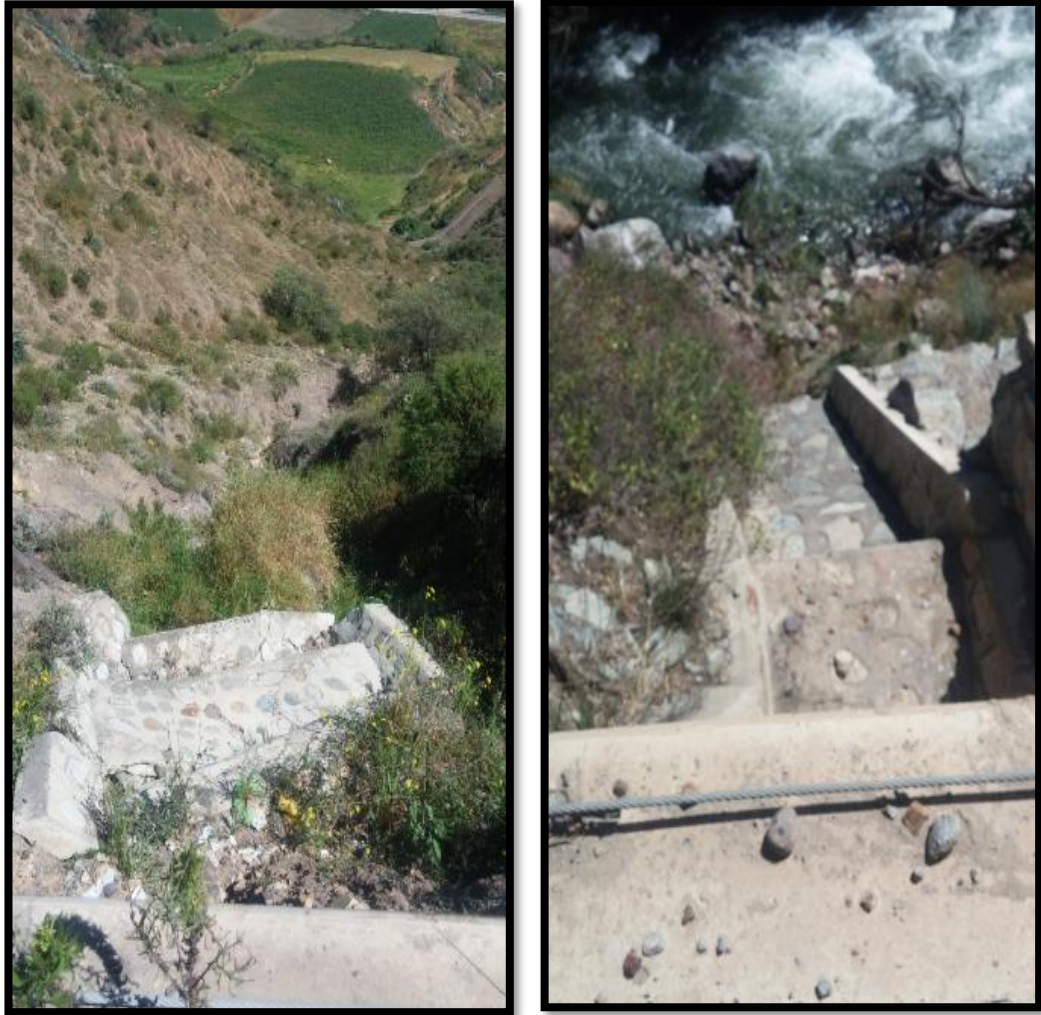
Figura 49. Cauce natural en las alcantarillas, por elaboración propia.
