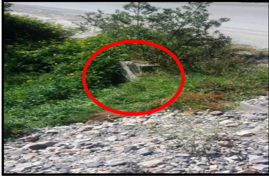
Figura 29. Fotografía a la salida de la alcantarilla, emboquillado en Km 32+130. Fuente: Propia.
