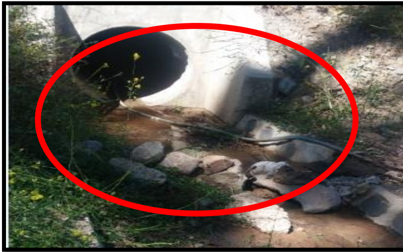
Figura 39. Fotografía a la salida de la alcantarilla, emboquillado en Km 76+700.
