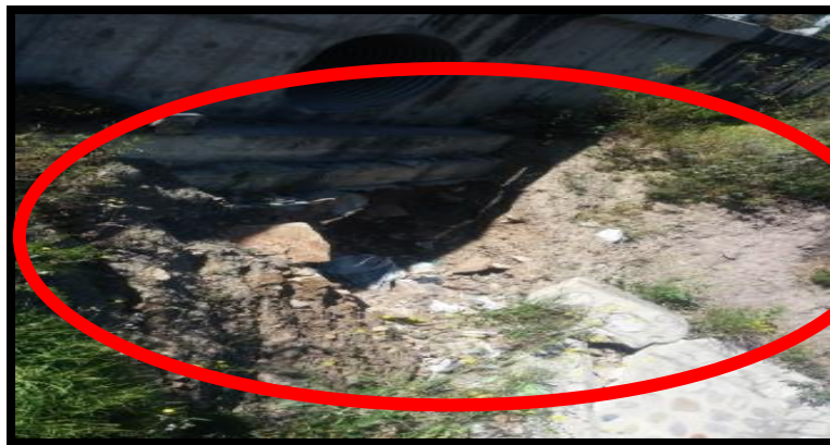
Figura 41. Fotografía a la salida de la alcantarilla, emboquillado en Km 76+892, por elaboración propia.
