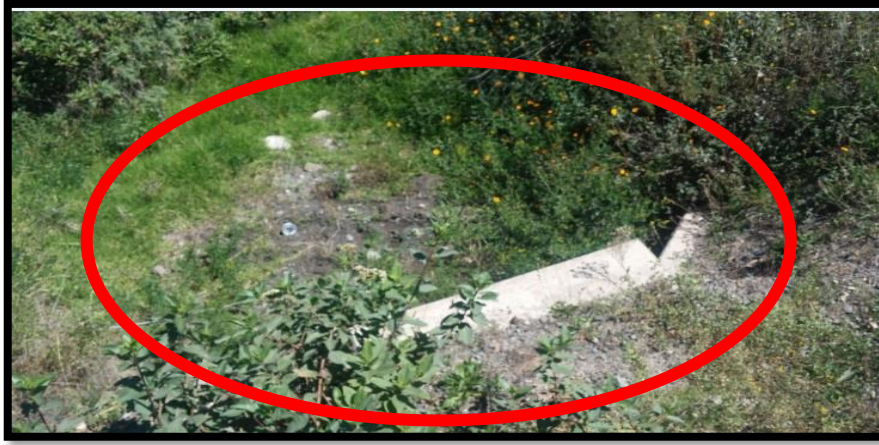
Figura 31. Fotografía a la salida de la alcantarilla, emboquillado en Km 64+810. Fuente: Propia.
