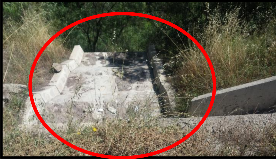
Figura 27. Fotografía a la salida de la alcantarilla, emboquillado en Km 30+160, por elaboración propia.
