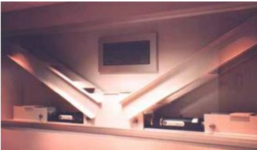
Figura 19. Configuración chevron brace
