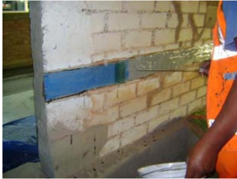
Figura 31. Aplicación de la resina Mbrace Saturant haciendo uso de rodillo Fuente: Bartolomé, 2010
