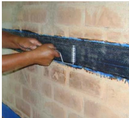
Figura 33. Segregación de la resina causada por aplastamiento del rodillo metálico Fuente: Bartolomé, 2010
