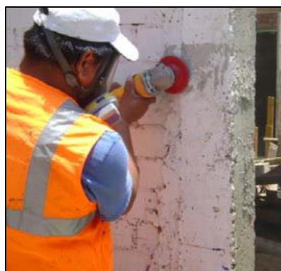
Figura 27. Aislado con esmeril en las zonas donde se colocarán las bandas
