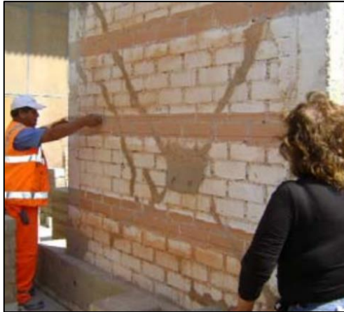
Figura 28. Alineamiento horizontal con el tiralíneas para la colocación de bandas
