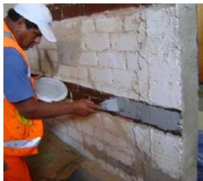
Figura 30. Aplicación del sellador Mbrace Putty haciendo uso de una espátula
