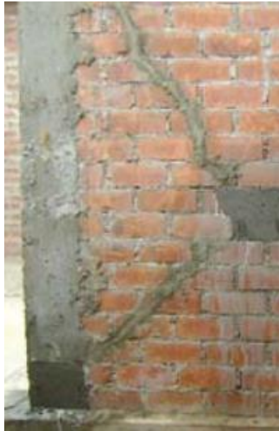
Figura 24. Relleno con concreto en las grietas y columna con previo aplicado del epóxico
