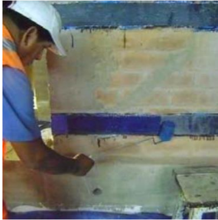
Figura 34. Colocación del epóxido sobre la banda para su encapsulamiento
