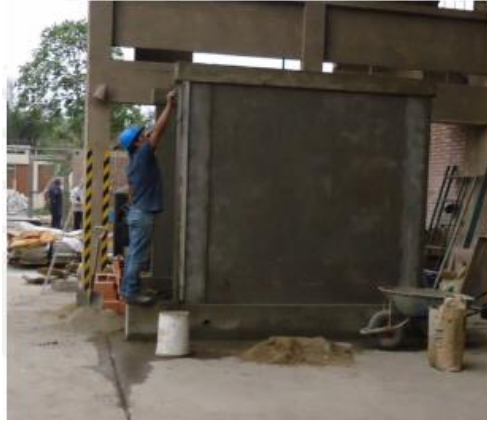
Figura 37. Vista final de la reparación con malla electrosoldada Fuente: Bartolomé, 2010
