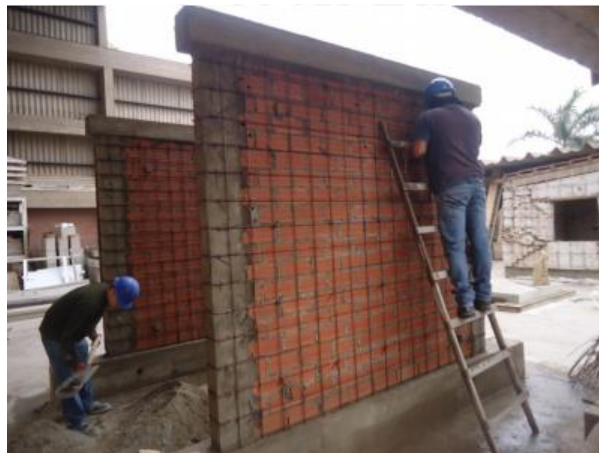
Figura 36. Vista del proceso constructivo en la instalación de mallas electrosoldadas
