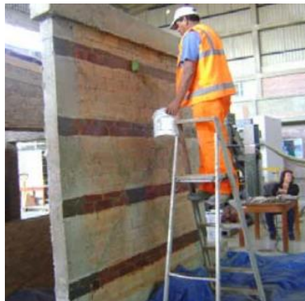
Figura 29. Aplicación del imprimante Mbrace Primer haciendo uso de rodillo
