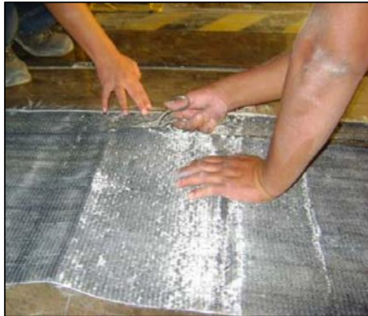
Figura 26. Corte de la fibra de carbono de acuerdo al ancho requerido
