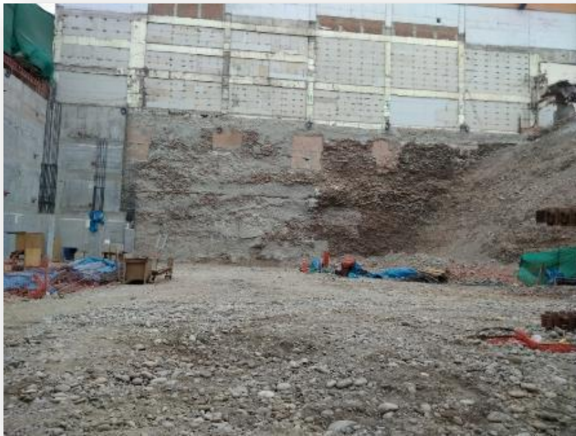
Muro anclado eje A.
