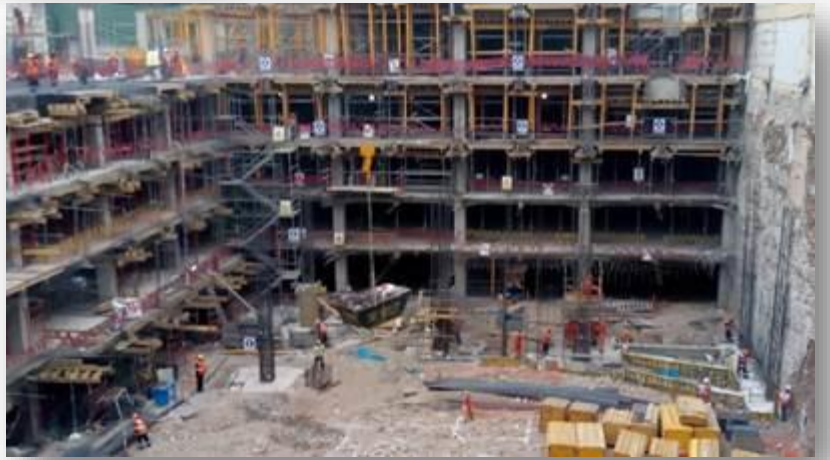
Trabajos en interior del proyecto
