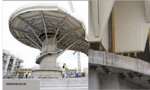
Este proyecto está compuesto por capas de madera micro laminada, la cual descansa sobre 6 núcleos de hormigón. Cada estructura de madera laminada posee 150 m de largo por 25 m de ancho y 28 m de alto, teniendo como retícula primera un ordenamiento de 1.50 m x 1.50 m.
