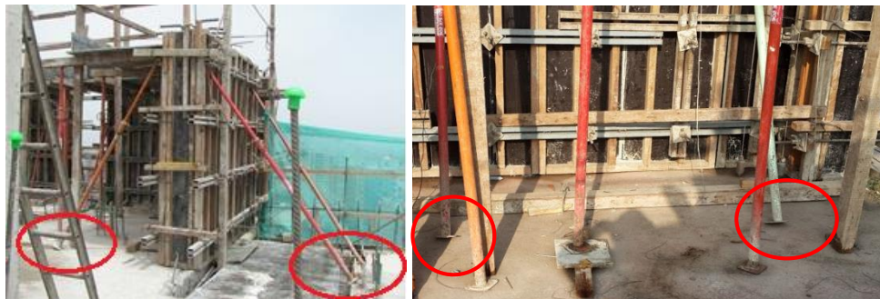
Fotografías tomadas en obra
