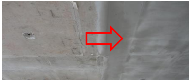
Fotografía tomada en obra
