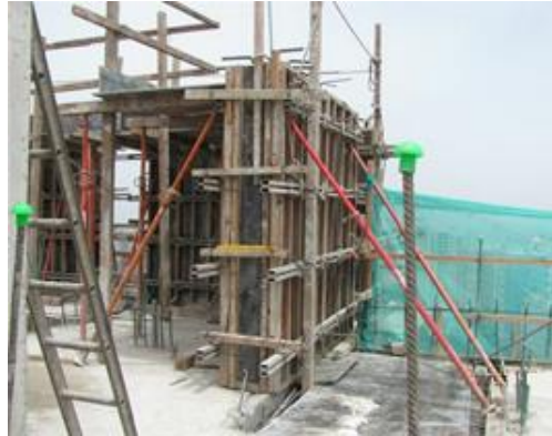
Fotografía tomada en obra
