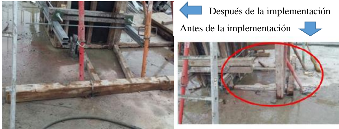
Fotografías tomadas en obra
