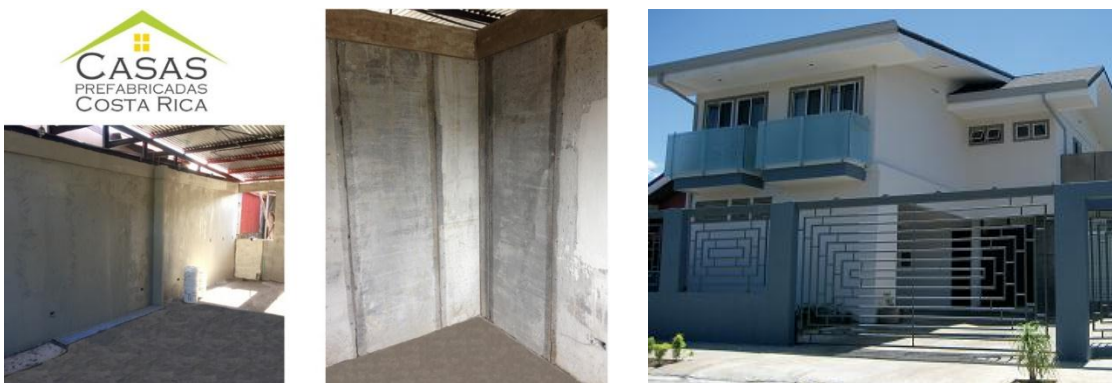
Imagen N° 1: Sistema de Paredes de Concreto Prefabricados de Concreto FACOLI Izquierda: asentado de muros para albañilería armada. Centro: paneles de concreto prefabricados modulares. Derecha: Modelo vivienda de dos pisos [25].
