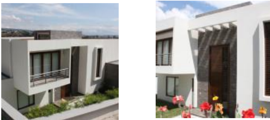
Imagen N° 6: Proyecto “La Primavera”, Arequipa. Con sistema constructivo EMMEDUE – Hormi2 Perú [27].
