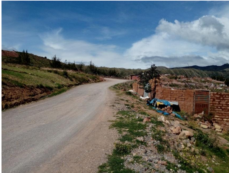
Imagen N° 23: Vista vía de acceso APV Alto Qosqo, como se observa la vía principal de acceso se encuentra en buen estado, la carpeta de rodadura es lastre y recibe mantenimiento periódico.
