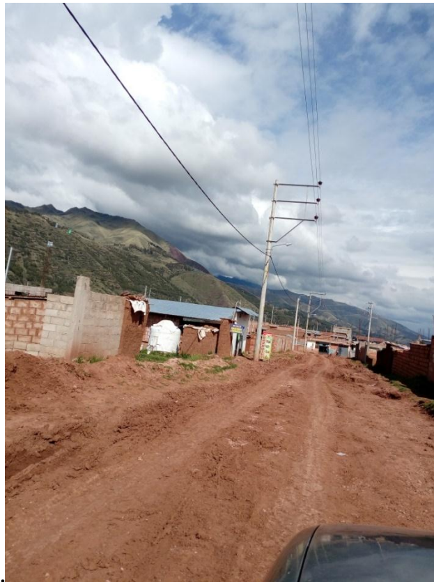
Imagen N° 25: Vista del sistemas de abastecimiento de agua de la APV Alto Qosqo, se observa que los pobladores cuentan con un tanque rotoplast para almacenar agua.
