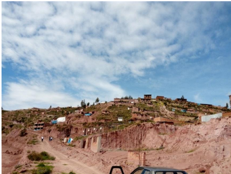
Imagen N° 24: Vista vías secundarias de acceso APV Alto Qosqo, se puede apreciar que las vías secundarias no reciben el mismo mantenimiento que la vía principal.
