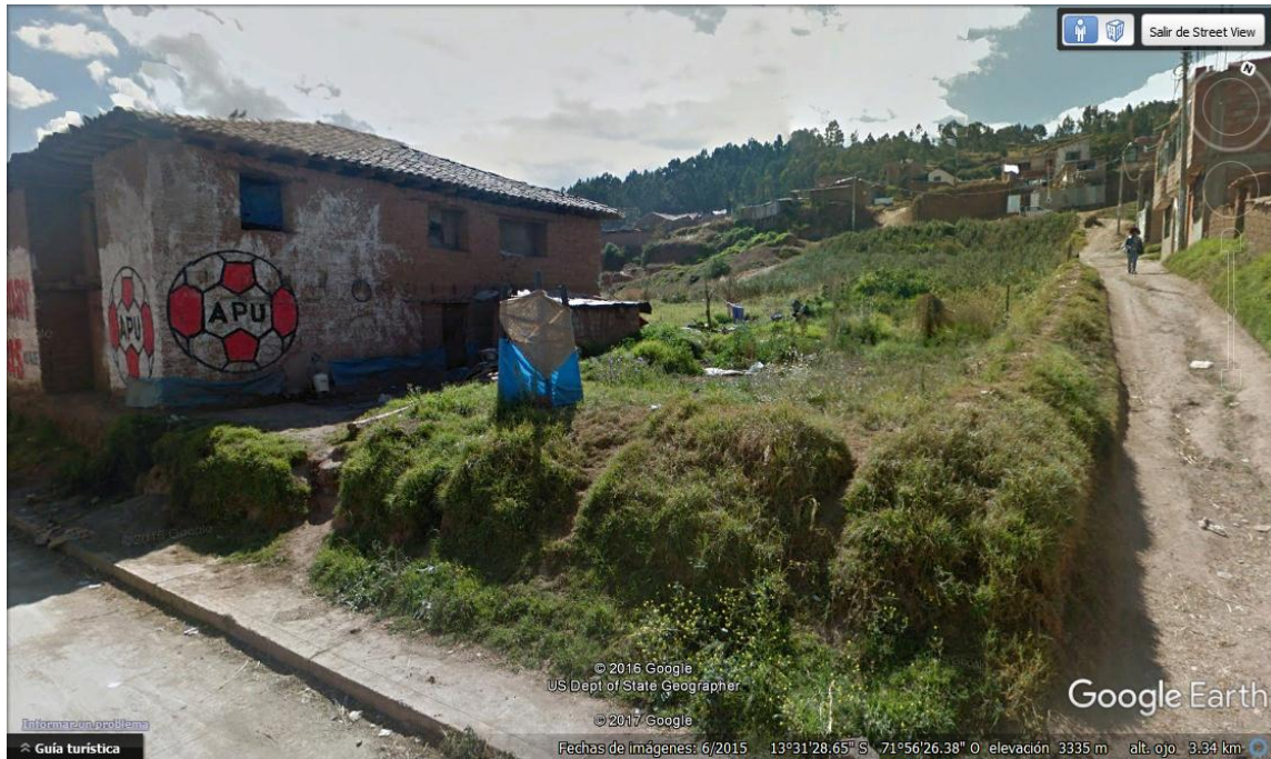
Imagen N° 17: Terreno propuesto para la ejecución del proyecto, se puede apreciar la existencia de electrificación e iluminación pública. Fuente: Google Earth
