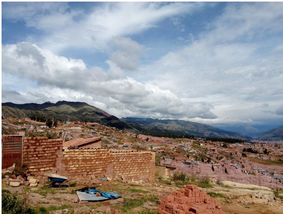
Imagen N° 22: Vista panorámica de la situación de viviendas en la APV Alto Qosqo, como se observa viviendas improvisadas y sin ningún tipo de consideración del aspecto estructural de sus viviendas.
