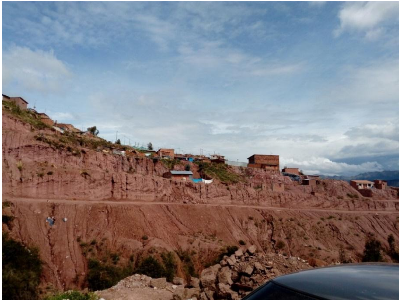
Imagen N° 20: Vista de la zona inicial de la APV Alto Qosqo, como se observa la topografía de la zona es accidentada donde se aprecia una quebrada.
