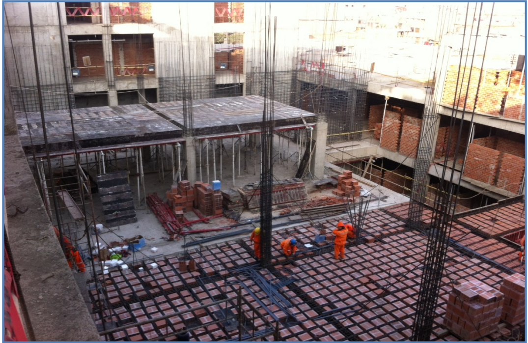
Foto N° 06.- Vista de techo aligerado del sector C3, próxima a colar concreto.
