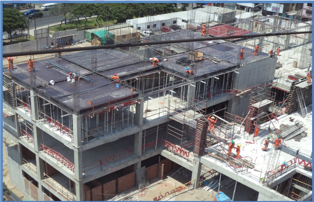
Foto N° 03.- Edificio Sector C.
