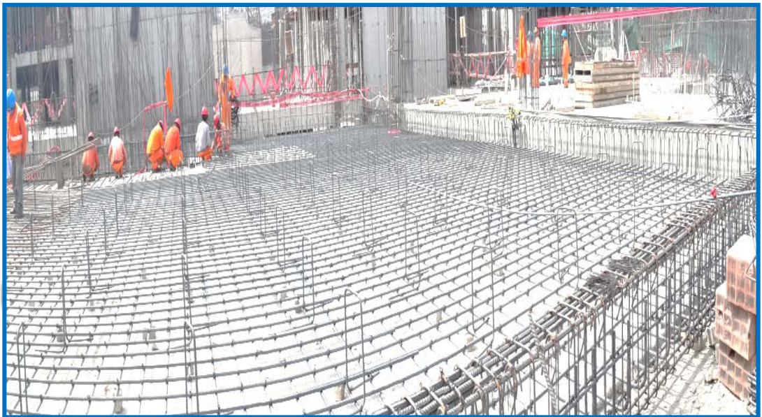
Foto N° 01.- Colocación del acero corrugado en platea y vigas de cimentación pertenecientes al Sector C1.
