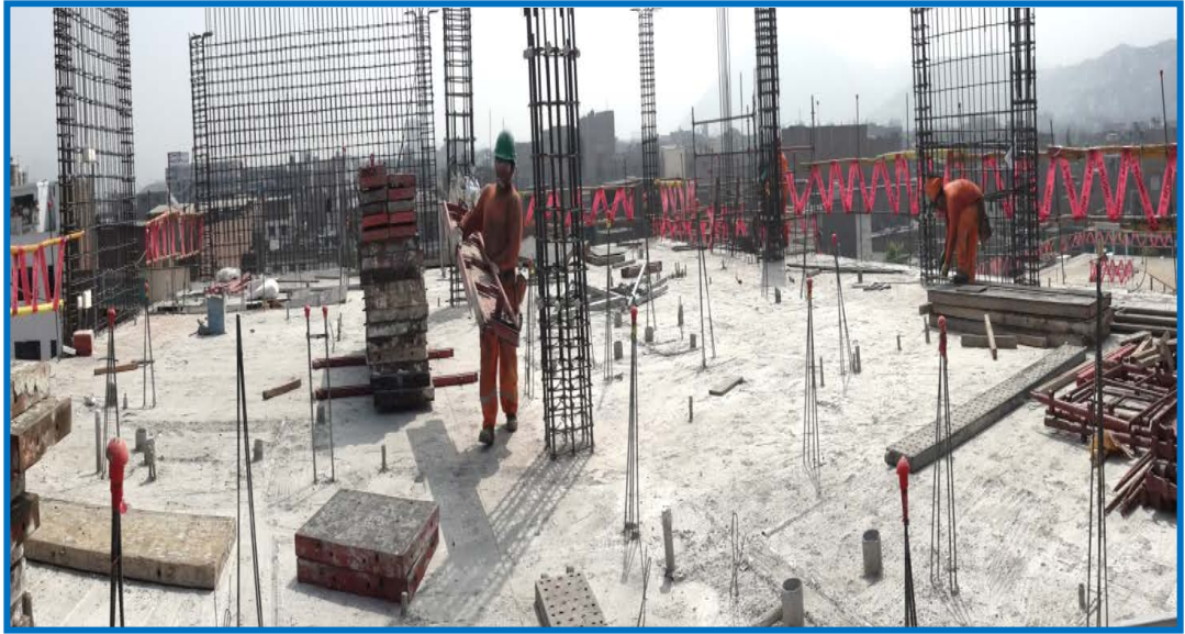
Foto N° 02.- Trabajo contributivo, actividad de “desplazamiento” de encofrado en el tercer nivel del Sector C3.
